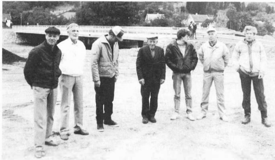
Arbeidsgjengen frå vegvesenet som har stått for det meste av byggearbeidet, og som har gjort eit framifrå arbeid, er her samla framfor brua. Frå venstre: Rasmus Rasmussen, Salve Hofsmo, Håkon Østrem, Ole Espelid, Oddvar Ollestad, Arvid Hetland og Jan Hove.
