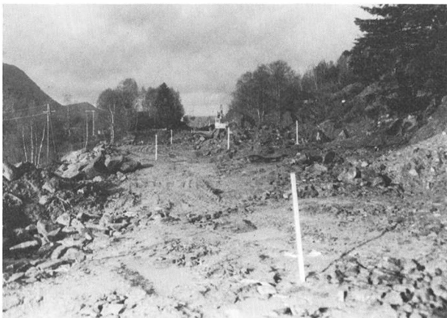
Glimt frå anleggsarbeidet hausten 1986.
