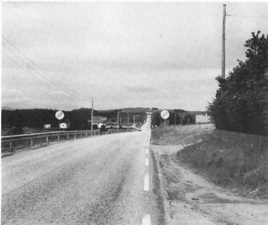
Rv 14 over Veasletta på Karmøy, en av strekningene som er satt i noenlunde god stand, men som er forholdsvis høgt ulykkesbelasta.
