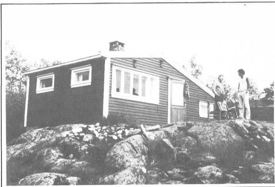
Flatlandshytta på Nedenes i Aust-Agder sett fra sør.
