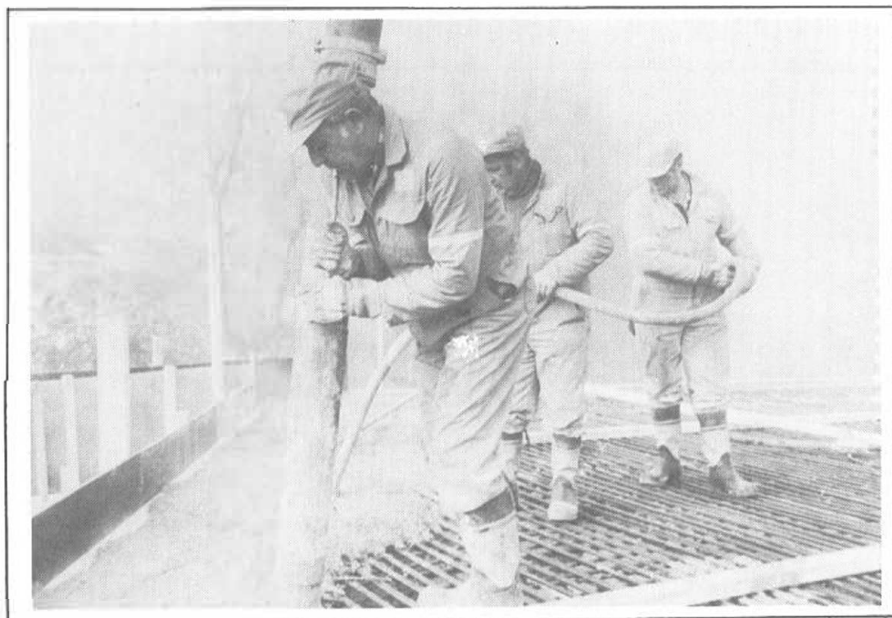
Dekket blir lagt. Raskt og effektivt blir betongen pumpa ut direkte frå tankbilten. Frå venstre: Rasmus Rasmussen, Sverre Espeland og Arvid Hetland.
