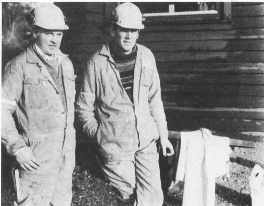
To av vegvesenet sine arbeidarar på veganlegget i Vats, Reidar Grinde t.v. og Jan Rossabø.
