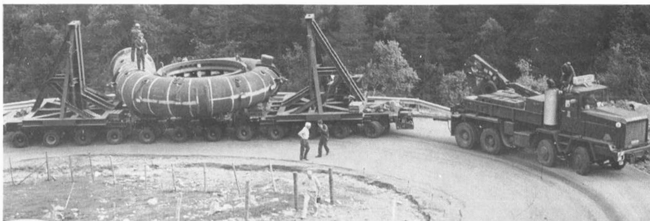
Turbinspiraltrømmel, eller «sniglehus», på veg til Kvilldal, el. last på over 100 tonn. Under anleggsperioden er det frakta kolli på opptil 226 tonn på vegar i Suldal. (Foto: Hans Chr. Rygh, Suldalsposten.)
