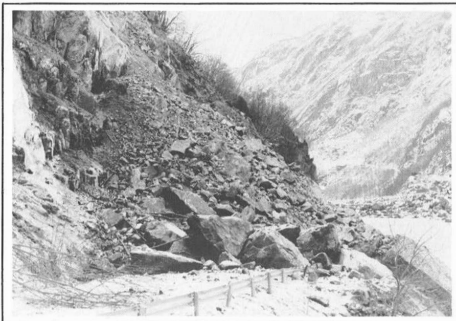
Biletet viser ein del av steinmassane som har rasa ned over vegen. Dessutan rasa ein god del rett ned i sjøen.
