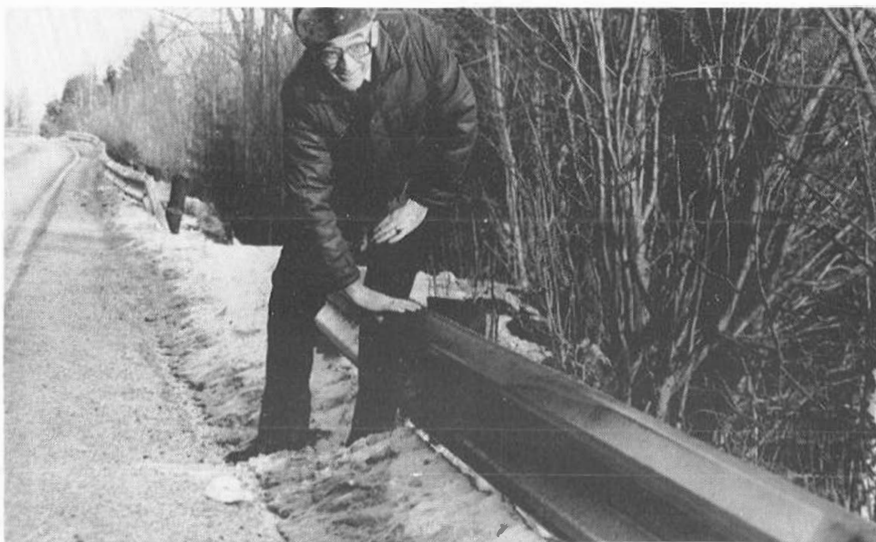
Karl Støle viser her et rekkverk som begynner å bli lavt ca. 0,45 m over vegbanen.
