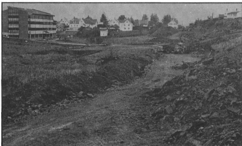
Den nye Stølebuktvegen, hvor den snor seg forbi det nye rådhuset i Kopervik.
