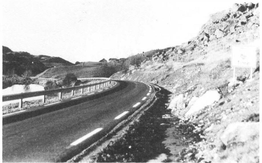
Ein del av den nye vegtraseen frå Mellomstrand i Time til Moi i Bjerkreim.
