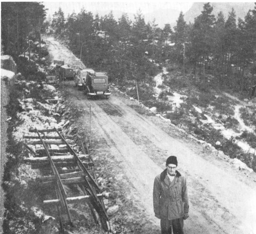
Frå anleggsarbeidet på Ryfylkevegen (rv 13) i Vormedalen 1955. Alfred Rake kom til Ryfylke og tok til som oppsynsmann på Ryfylkevegen i 1945.
