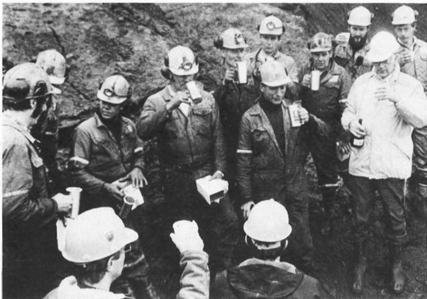
Samling på røysa til «kranseskål» etter gjennomslaget. Krusa som blir brukte er tinnkrus som arbeidarane fekk frå Stavanger kommune for vel utført arbeid.
