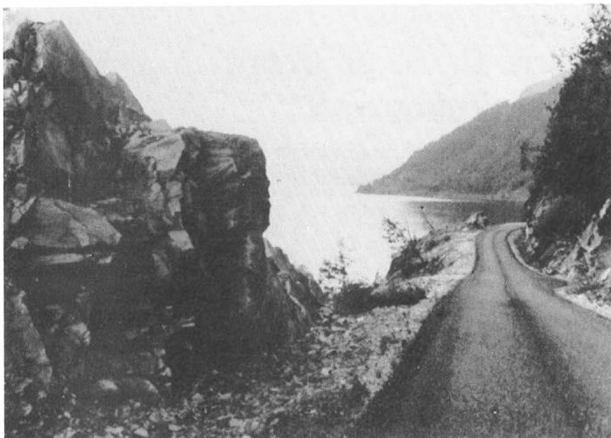
Parti av den nye vegen frå Tengesdal og utover langs Hylsfjorden mot Vandvik.
