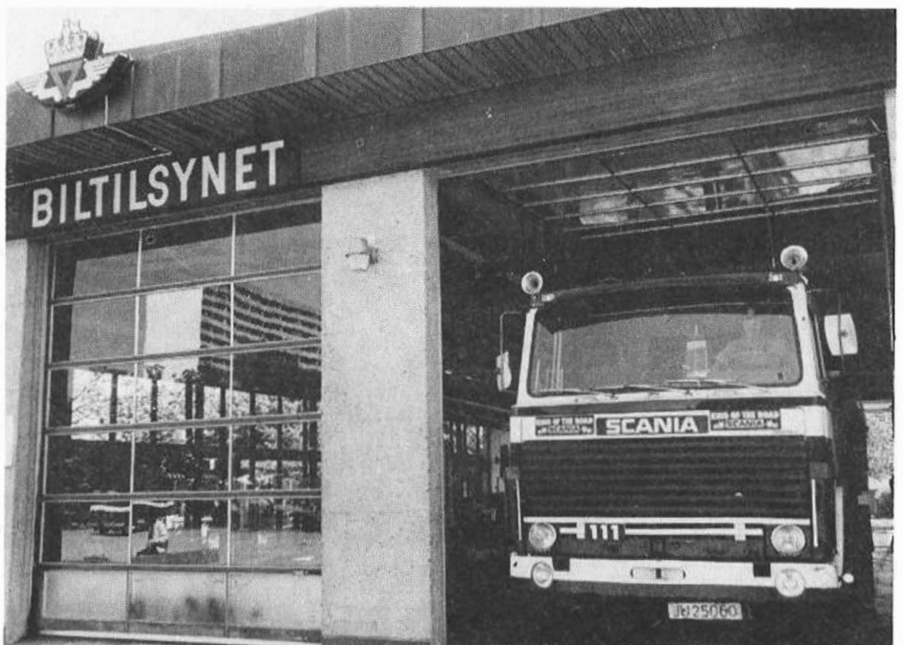
Kontrollhallen ved Biltilsynsstasjonen i Stavanger.
