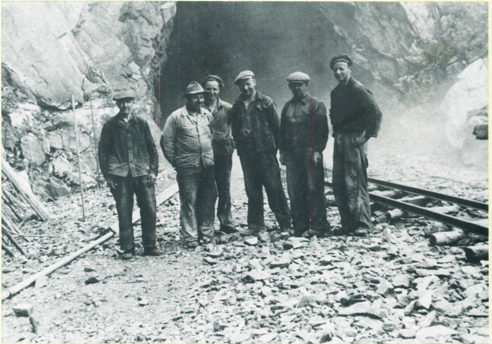
Arbeidslag på tunnetarbeid i Ivarsflaten tunnel ovanfor Solheimsvik i Suldal i 1950. Frå venstre: Erik Helganes, Johan Andersen, Ragnvald Tveit, Steinar Tveit, Vagleik Littlehammar og Lars Tveit. Biletet har me lånt av Lars Tveit.
