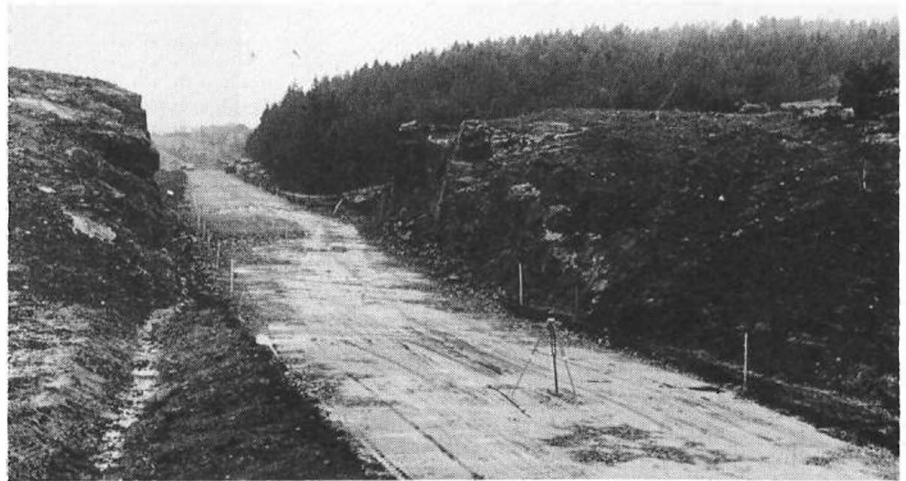
Mellom dei viktige prosjekta som blir fullført i neste planperiode er ny innfartsveg (E—76) til Haugesund.
