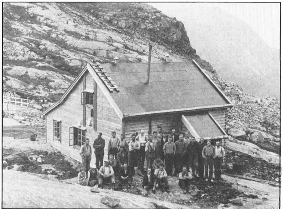
Arbeidarar på Trollstigvegen utanfor brakka på Stigfjellrøra ca. 1930. Nr. 11 frå venstre er Ole Tafjord, som arbeidde på Trollstigvegen i 9 år, frå 1926 til 1934.
