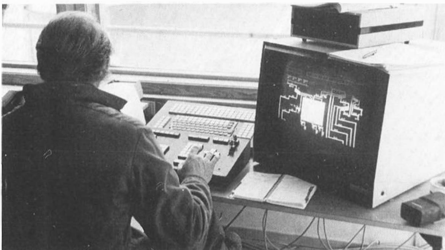
Frå kontrollrommet er det oversyn over heile anlegget. Alt blir kontrollert og styrt via dataanlegg.
