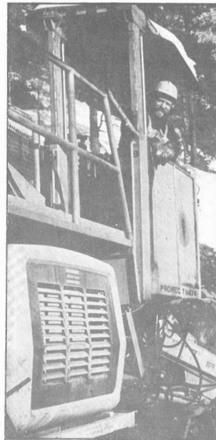
Torleif Halvorsen i arbeid på den eine av dei to borebyggene som blir nytta på anlegget Hustveit – Svandalsfossen.
