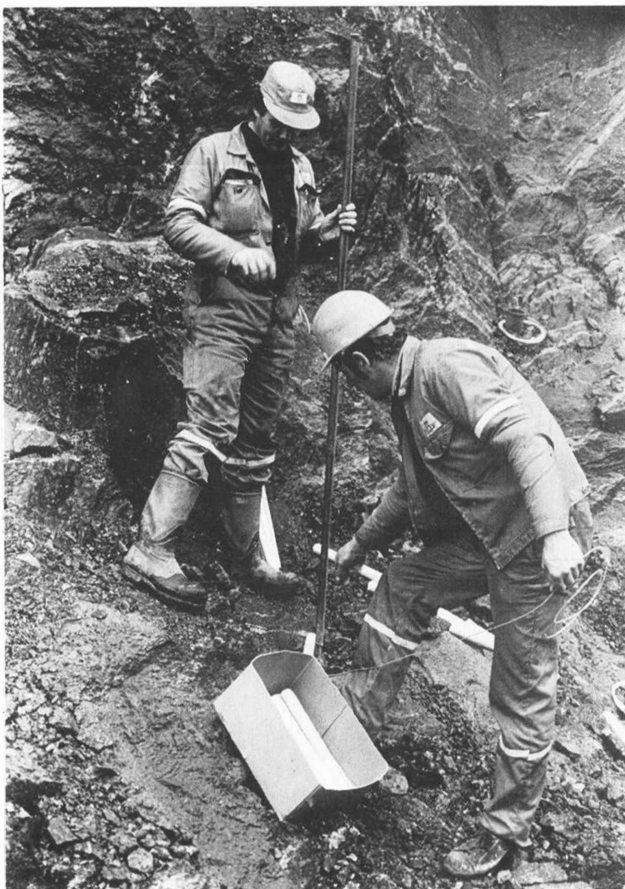
To av de arbeiderene på innfartsveien til Haugesund som er delaktige i den rimelige og effektive framdriften på anlegget. Formann Sverre Kvinnesland (med ladestaven) og Jan Rossabø.
