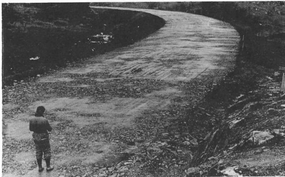
Arbeidet med ny E 76 (innfartsveg til Haugesund) frå Toskatjønn til Karm-sundsgt. vil halda fram langs heile strekninga i 1985. Biletet viser den nye traseen over Gamlamyr i retning mot Ørpetveit i okt. -84. Ingen delar av anlegget vert sett under trafikk i 1985.
