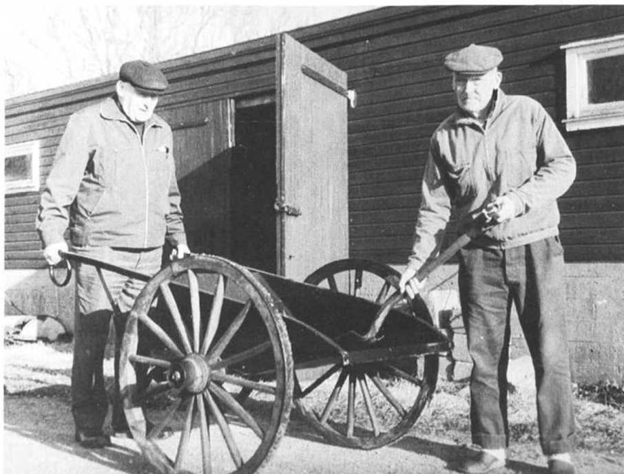
Lars Svihus, pensjonert sjåfør, (t.v.) har skaffa til veie og tatt vare på mange gamle vegredska. Her er han utenfor brakka på Laland, der gjenstandene er lagra, med ei kjerre. Denne ble brukt til å kjøre grus i vedlapping av vegbanen. Pensjonert vegvokter Karl Seime med skufla viser hvordan det gikk for seg. Seime bor tett ved brakka, og fører tilsyn med den og samlingene.
