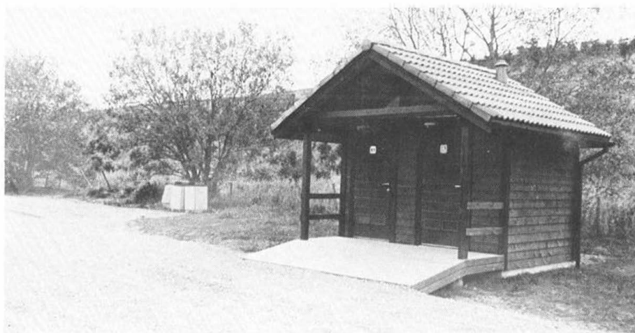
Det nye toalettanlegget ved E 18 på Søyland i Gjesdal.
