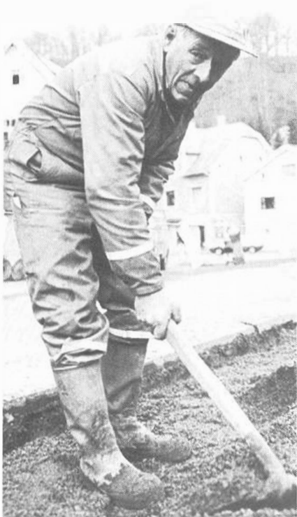
Ole Espelid i arbeid med å planera eit fortau på vegen frå Haugekrossen mot Rekefjord/Sogndalstrand.
