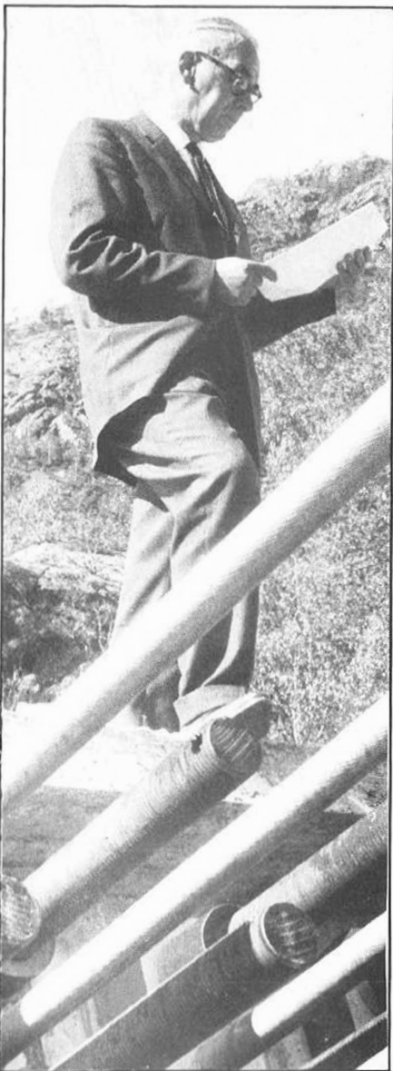
Gimnes orienterer om Erfjordbrua under ei synfaring som fylksveg-nemnda hadde under byggeperioden i 1965. (Foto: Stavanger Aftenblad)
