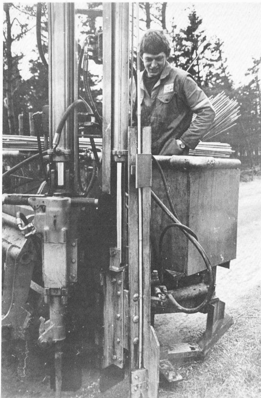
Bildet viser stikkmaskinen, som er tilkoppa ein shovel, i arbeid. Nederst til venstre ser me den hydrauliske hammaren med telebrekkarspennet. Når holet er stukke, dreier matesylindern (midt på bildet) over til den posisjonen hammaren hadde, og stikka blir pressa ned i holet. På maskinen, Kåre Taksdal, som legg stikkene til rettes for den hydrauliske sylindern. Foto: Harald Sel.
