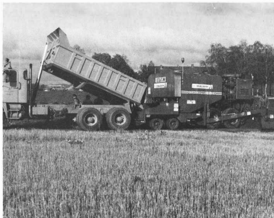
Legging av skum-asfalt for Statens vegvesen i Akershus i fjor sommer.
