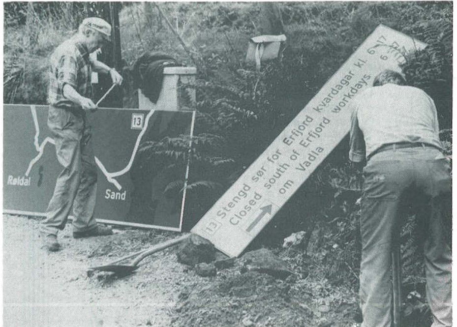
Ragnvald Vårvik og Tor Vårvik er her i arbeid med å montera opplysningstavle/skilt på rv. 13 ved Sand, dagen før sprengingsarbeidet tok til. I anleggsperioden på Strekninga Hålandsosen—Vindsvik går trafikken for det meste på fylkesveg 632, Indre Eiane—Vadla—Mo. Foto: Harald Sel.
