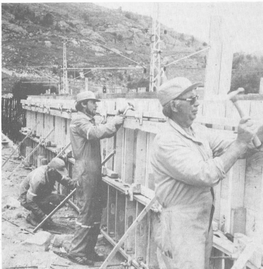
Frå arbeidet med forskalingsarbeidet til sikringsmuren mot jernbanen. Frå venstre: Dagfinn Ålgård, Håkon Østrem og Georg Midbrød. Også på øvre sida av vegen, på stupkanten mellom bolighusa og vegen, blir det sett opp sikringsgjerdene.
