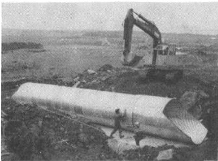
Montering av feundergang på — Kårstø.
