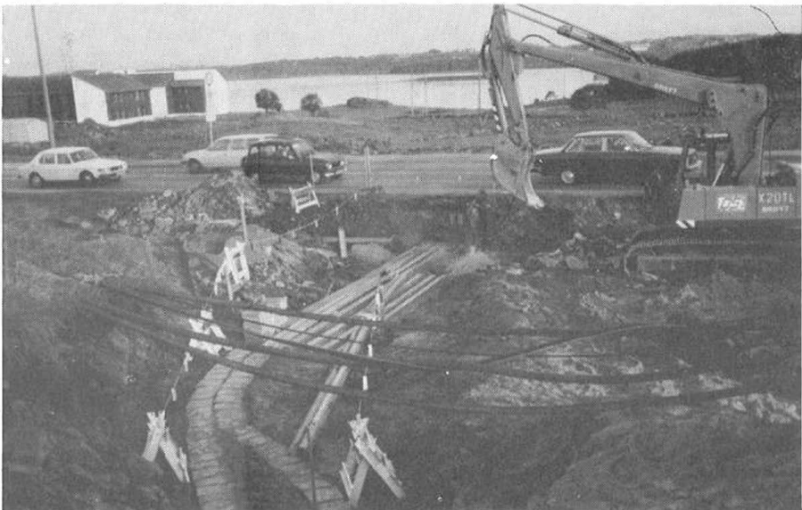
Leif Kjell Oaland borer før sprenging. Det sier seg selv at med så mange kabler og en årsdøgntrafikk på omlag 17. 000 kjøretøyer måtte sprengingsarbeid gjøres med stor omhu.
