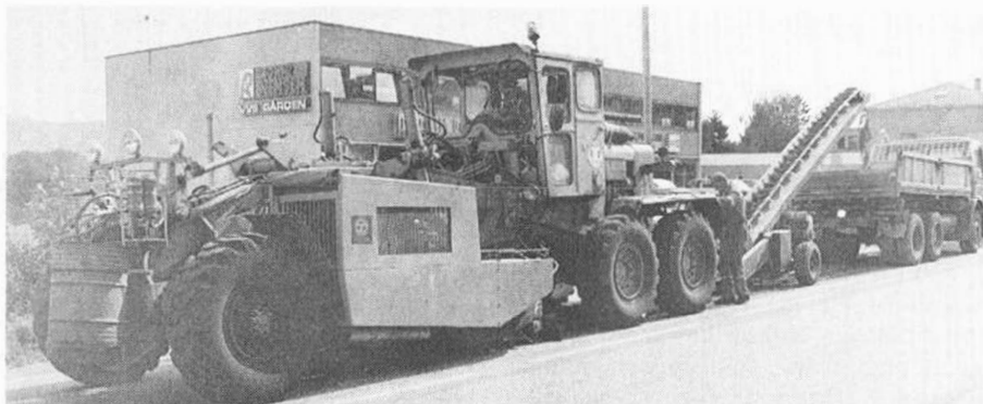
Asfaltfresing på riksveg 44.
