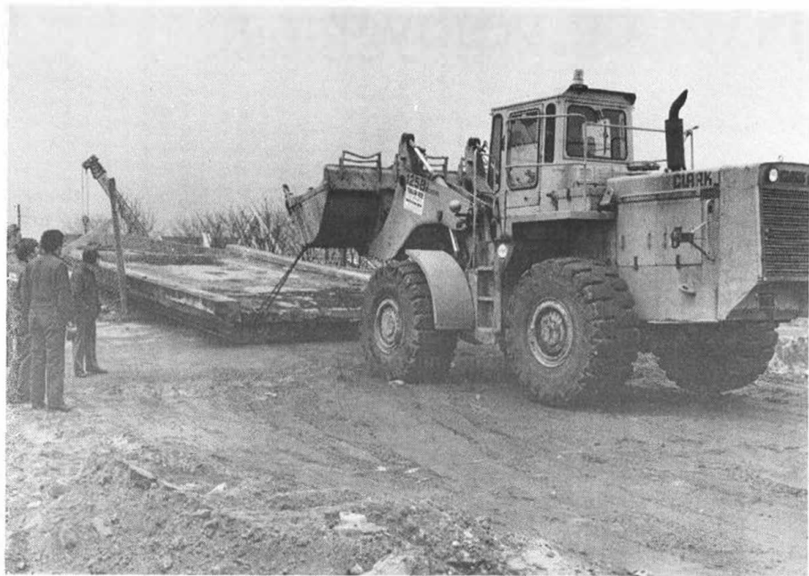
«Rå kraft» ble brukt for å trekke dekket bort fra brukaret.
