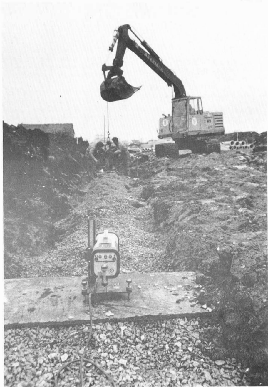
Laser'en gir nøyaktige høyder for legging av rør.
