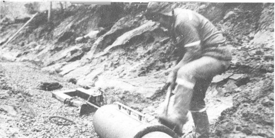
Odd Egil Narten justerer høyden på avløpsrøret.
