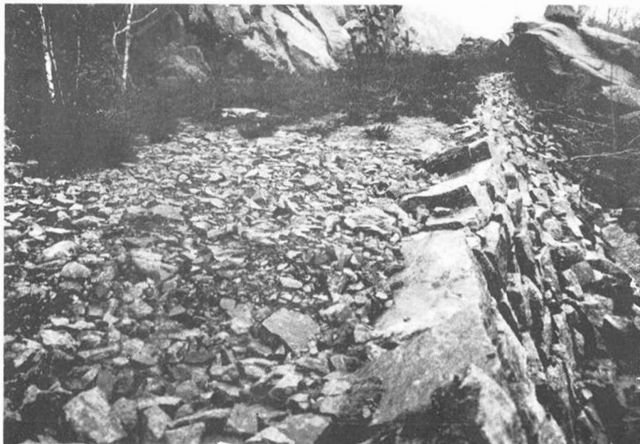
Vi ser her noe av vegen som ble bygget like etter siste verdenskrig. Til høyre på bildet ser vi en del av muren som forsvinner i fyllingen. Foto: Ole Handland
