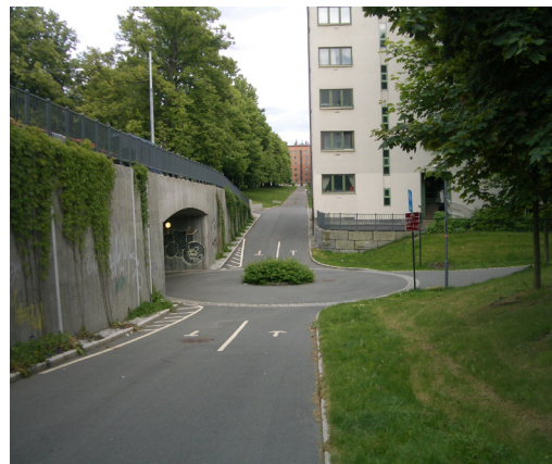
Chr. Michelsens gate, Oslo. Bred udergang med rundkjøring og adskilte kjøreretninger for syklistene. I selve udergangen er arealet for fotgjengere og syklistene adskilt. Foto: Finn Aslaksen.
