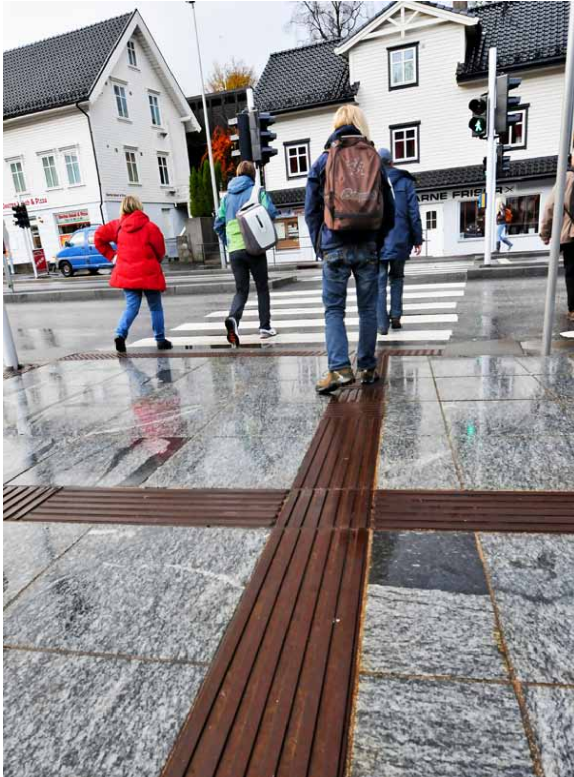
Kunstige ledelinjer i støpejern. Kontrasten er god mot øvrig gategrunn og retningsindikatoren har en bredde på 30 cm, noe som er i henhold til anbefalingene. Retningsindikatoren anbefales imidlertid lagt inn mot midten av varsselfeltet foran gangfeltet, og det burde vært lagt oppmerksomhetsfelt inn mot retningsendringen. Foto: Knut Opeide.
