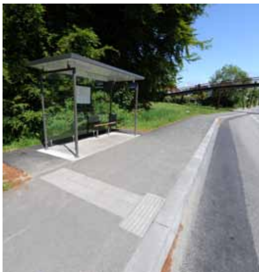
Holdeplass med riktig utformet kunstig ledelinje, men der lehus er plassert feil iht. anbefalinger. Foto: Finn Aslaksen.
