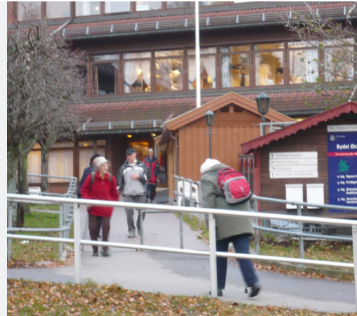
Oslo, gangveg til eldrester på Oppsal. Her er det rekkverk som gir støtte til personer med problemer med å gå og som fungerer som ledelinje både når det er bart og når det er snø. Foto: Paal Sørensen.
