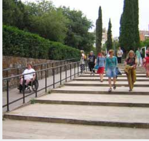
Barcelona. Rampe og trapp i en likeverdig løsning. Foto: Elin Katrine Nilsen.
