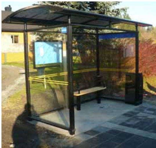
Porsgrunn, Mule. Lehus med benk med armlene, plass til rullestol, kontrastmerking, oppmerksomhetsfelt til påstigning og steinheller på arealet foran lehuset. Foto: Ragnar Grøsfjeld.
