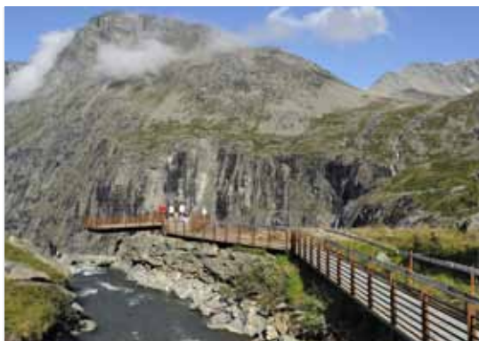
Utsiktspunkt for alle! Nasjonal turistveg ved utsiktspunktet på toppen av Trollstigen har trinnfri atkomst, rekkverk og kontrastfarge på rampen mellom servicebygget og utsiktspunktet. Foto: Jarle Wæhler/Statens vegvesen.
