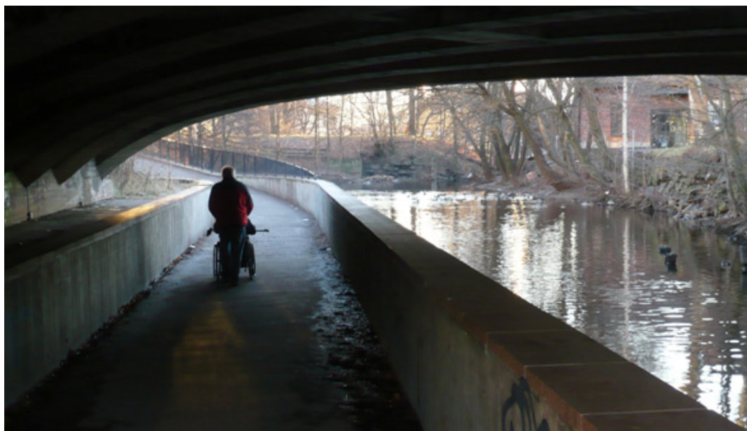
Oslo, gangveg/turveg langs Akerselva. Gang-veien er lett å følge med "rekkerk" i form av flom-sikring. Det er også ordinært rekkerk (i bakgrunnen på bildet). Foto: Paal Sørensen
