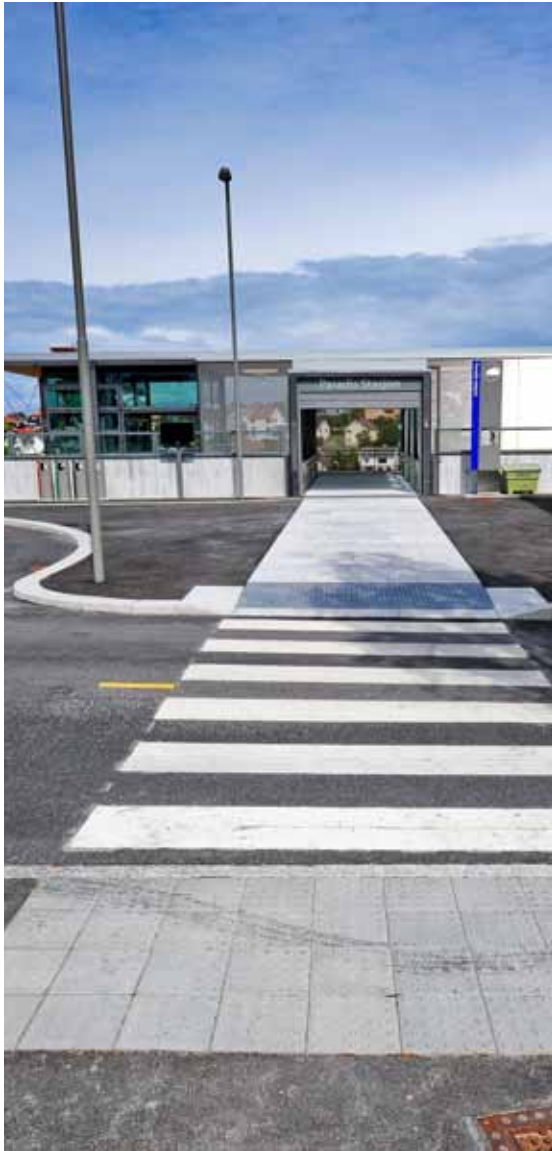
Tydlig markering av gangfelt. Kunstige ledelinjer utgjør et varselfelt i tilstrekkelig dybde, nedsenket kantstein og variasjoner i bruk av belegning, gjør det enkelt å finne krysningspunktet og krysse vegen. Foto: Knut Opeide.
