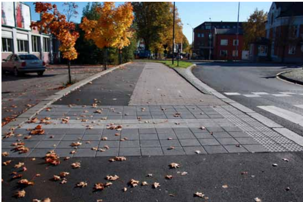
Tønsberg sentrum. Fotgjengerovergang med kunstige ledelinjer utformet i tråd med anbefalingene i håndboka. Naturlig ledelinje (kantstein) leder frem til krysningspunktet. Foto: Ole Thorleif Bommen (Asplan i Skien).
