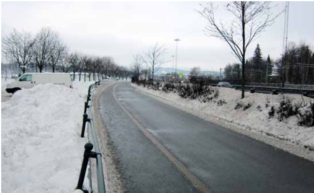
Frogerstranda. Sykkelveg med fortau. Gående og syklende er fysisk adskilt med kantstein og høydeforskjell. Fortau til venstre i bildet. Foto: Finn Aslaksen.
