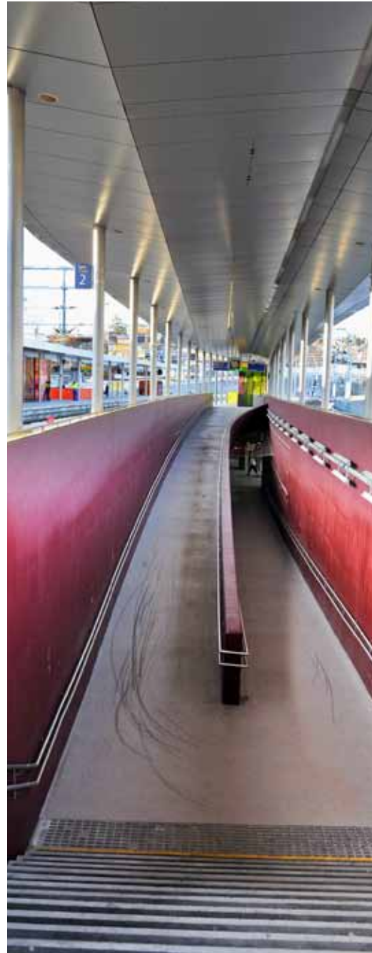
Trapp og rampe er anlagt på samme sted og løsningene fremstår som likeverdige. Trapp og rampe har også rekkverk i to høyder, markering av trinn og varselfelt foran trappens begynnelse. Eksempelet er fra Lysaker stasjon. Foto: Knut Opeide.
