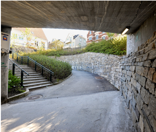
Undergang med slak stigning og tilstrekkelig fri bredde. Trapp er anlagt som et supplement og muren til høyre fungerer som en naturlig ledelinje. Foto: Knut Opeide.
