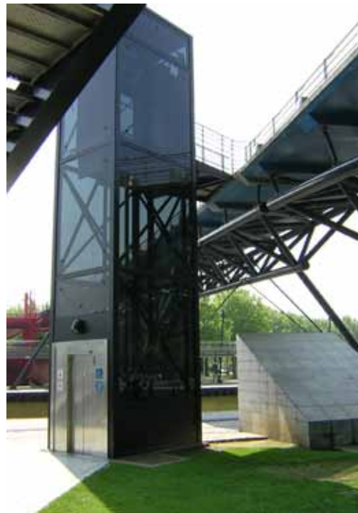
Paris Frankrike. Heis ved gangbro. Foto: Elin Katrine Nilsen.
