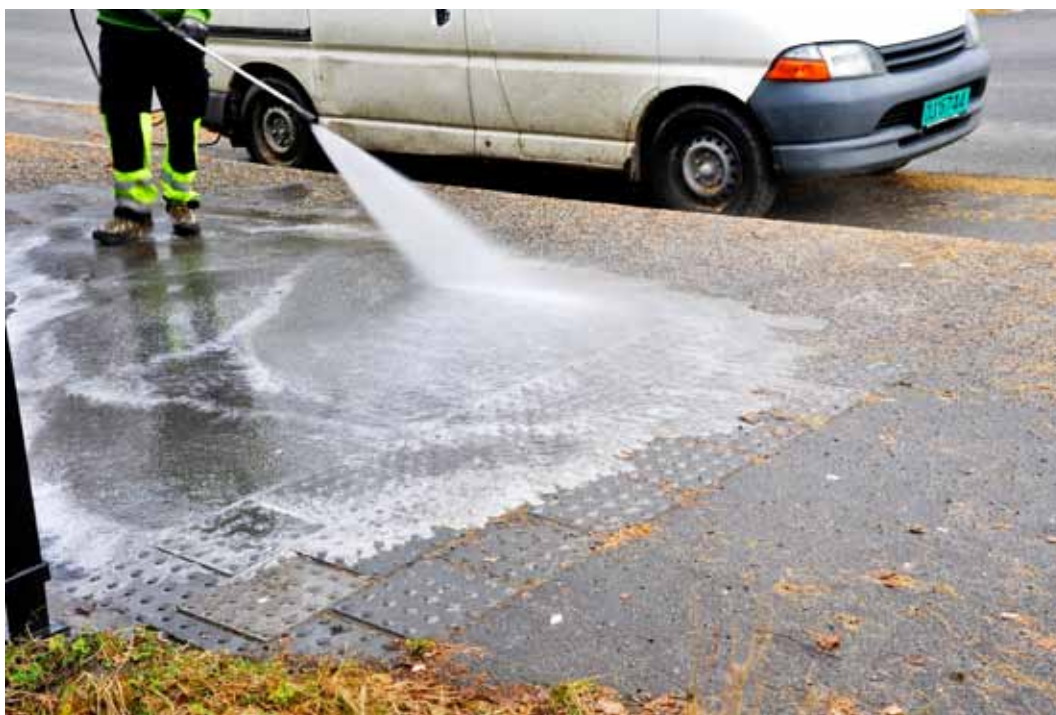
Drift og vedlikehold er avgjørende for å opprettholde bygd kvalitet og funksjon over tid og gjennom året. Her illustreres dette ved spyling av kunstig ledelinje på en holdeplass. Den kunstige ledelinjen er ikke i henhold til anbefalingene i håndboka. Foto: Knut Opeide.
