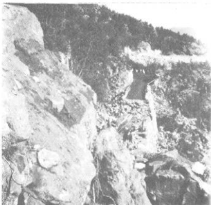
Veggen er her ferdig fram til forstøtningsmuren midt på bildet. Vi ser to mann som arbeider med muren. Steinene i forgrunnen skal tydeligvis fjernes. Ingen liten jobb med hånd-boring.
