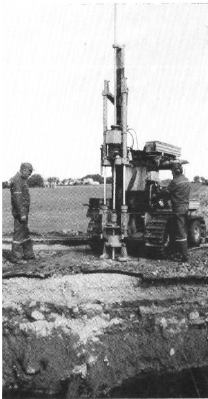
Magne Bjelland og Leiv Høye borer hull til sprengladningen.
