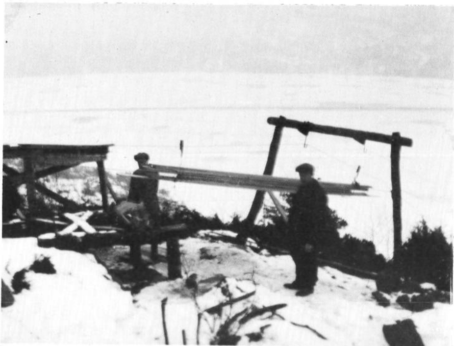
Materialer ble trukket opp fra sjøkanten med taubane.
