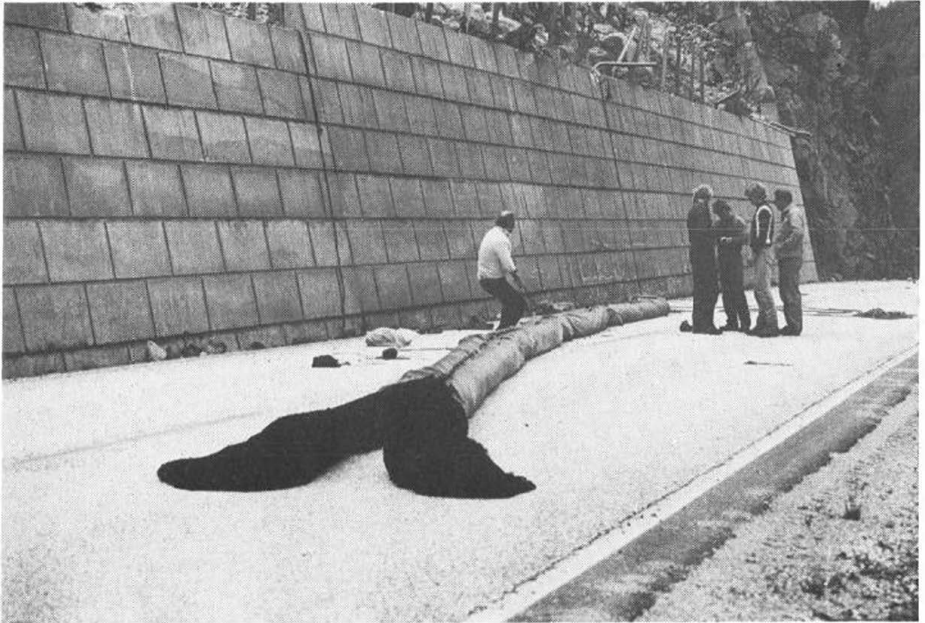
Nettet blir pakket inn i presenninger før det heises opp til toppen av skråningen.
