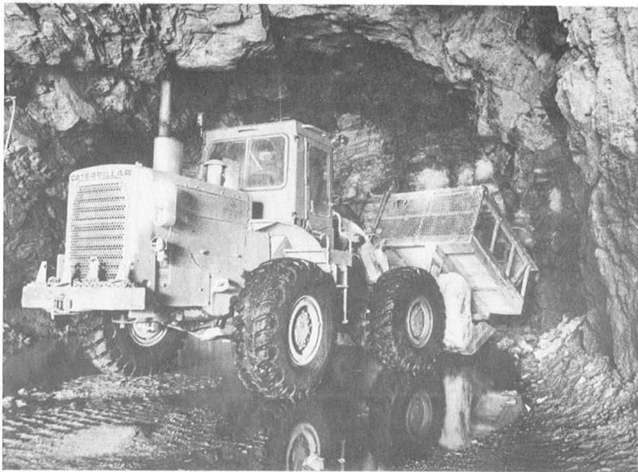
Tunnelrensk i Varmkro tunnel.
