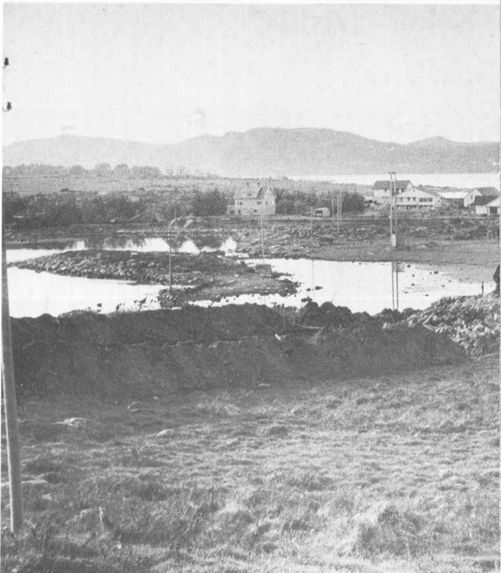
I Vaulavika var omlag 100 m bygget av den nye vegen da dette bildet ble tatt i begynnelsen av juni.
