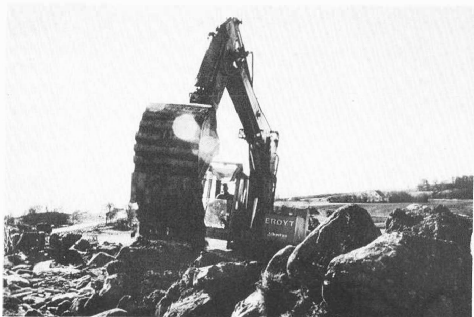
Ryddingsstein legges i vegkroppen på den nye fylkesvegen. Foto: Ole Handeland.
