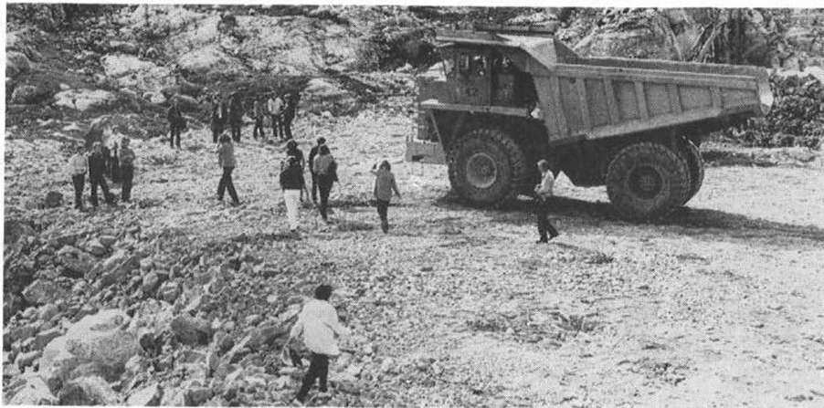
Vi VAR ikke store og FØLTE oss ikke store ved siden av maskinene på Ella-Førre-anlegget.
