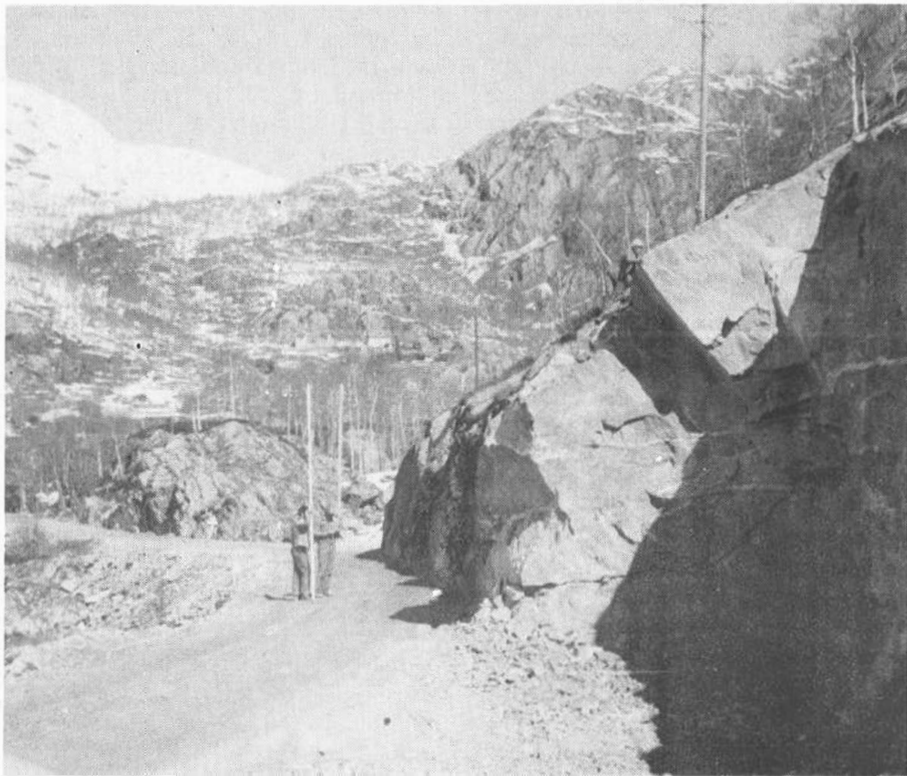
UTVIDELSE AV RV. 46 ROGALAND GRENSE – RØLDAL. Stikningsarbeid. Den gamle vegen gir såvidt plass for en lastebil.
