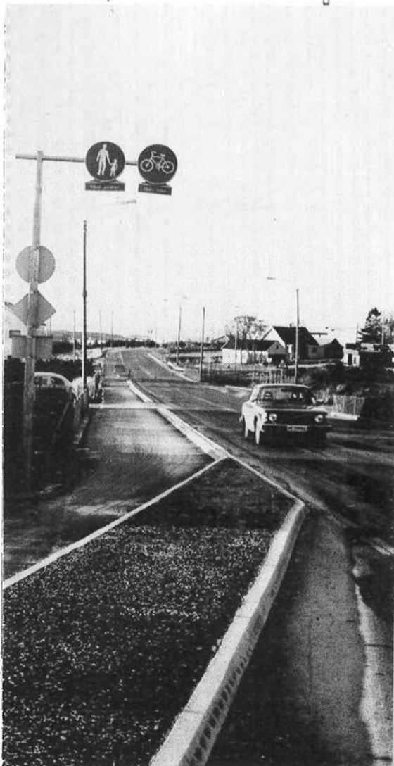
Sykkel- og gangveg ved Sundbråtet på rv. 509.
