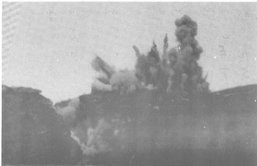
En salve sprenges på Bærheim.
