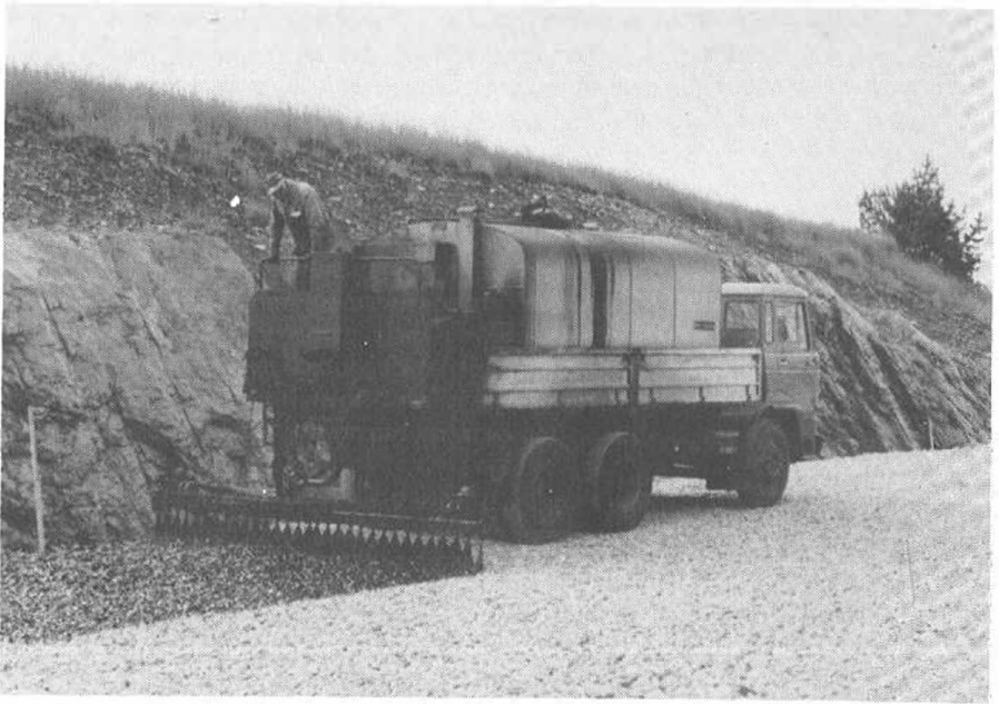
Bærelag av finpukk oversprøytes med flytende asfalt (bitumen).
