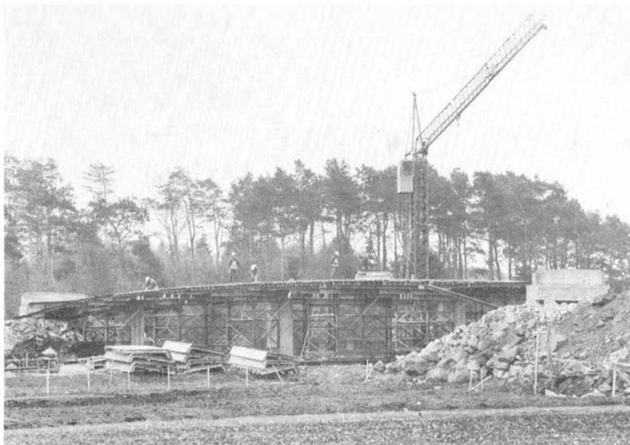
Bruarbeider på motorvegen syd for krysset med Grannesvegen.
