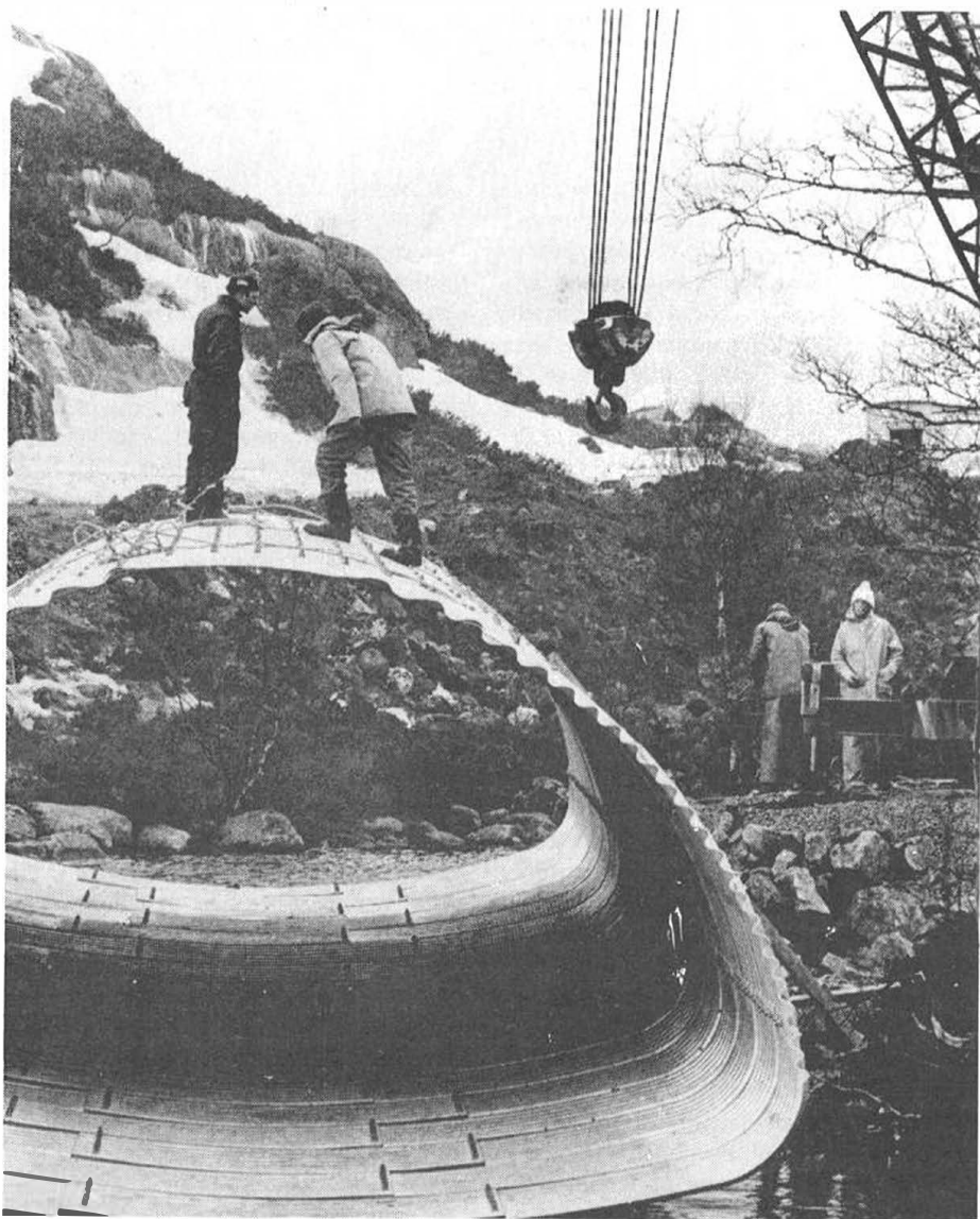
Monteringsarbeid ved Mydland bru.
