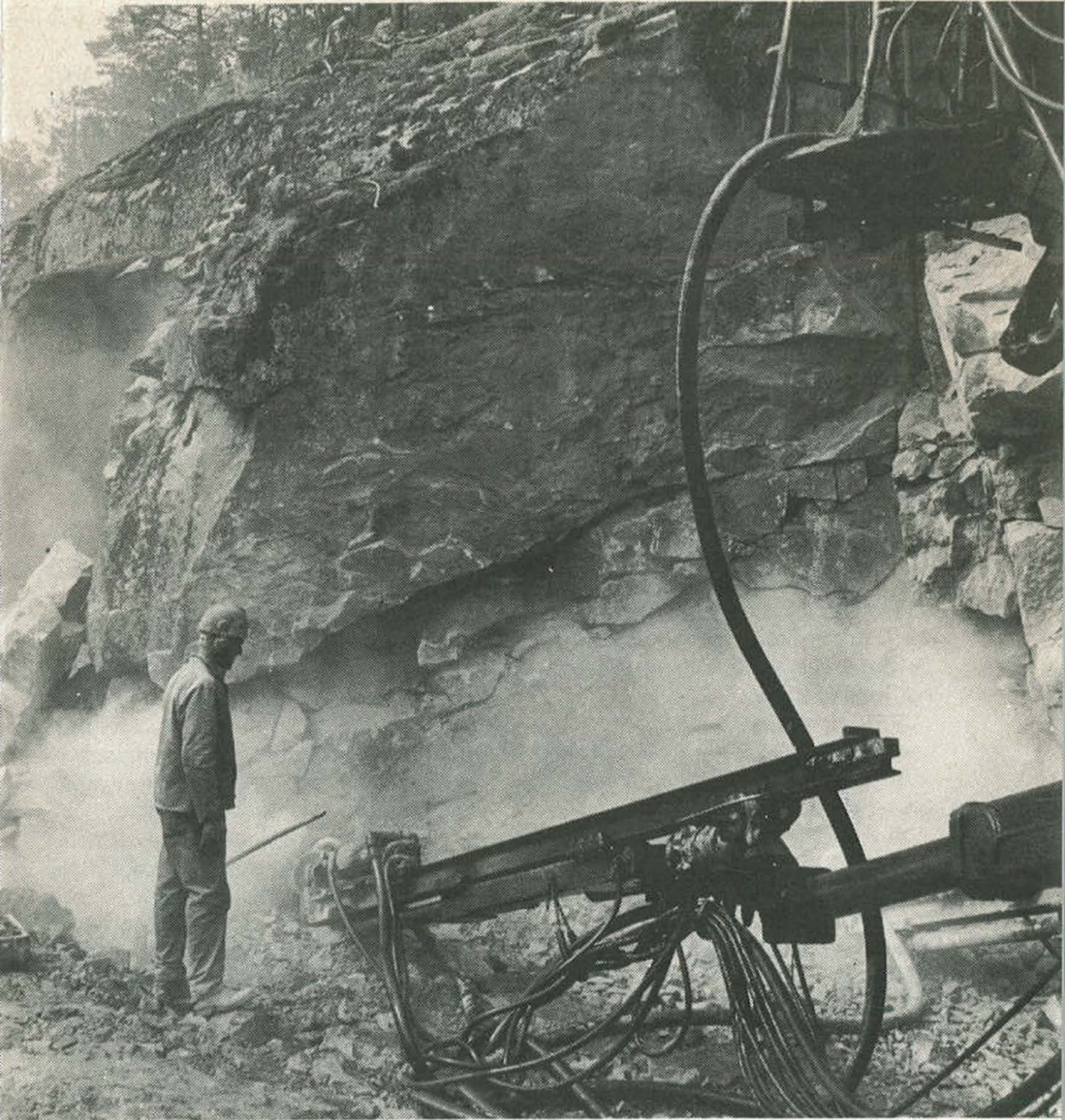
Tunnelrigg i arbeid på Ropeidvegen.
