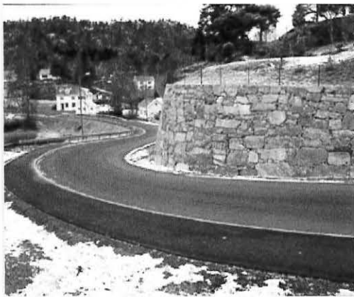
Fortau og fin mur ved Songe Skole.
