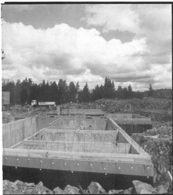
Byggearbeidene på Arendal trafikkstasjon begynte i april.
