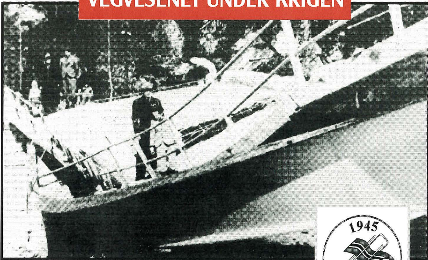
Skåre bru i Vegusdal etter sprengingen 11. april 1940.
