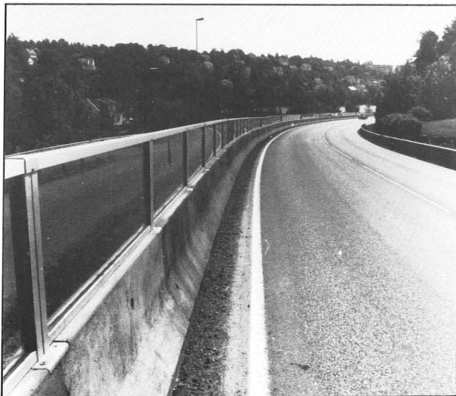
285 meter ny type støyskjerm er satt opp ved Langsæveien.
