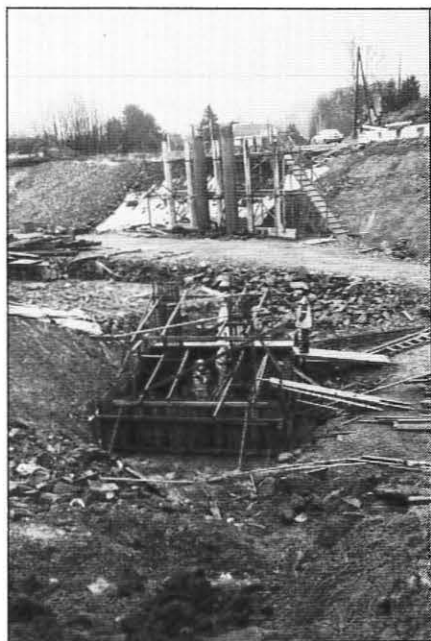
Byggingen av Ramleth bru er i full gang.
