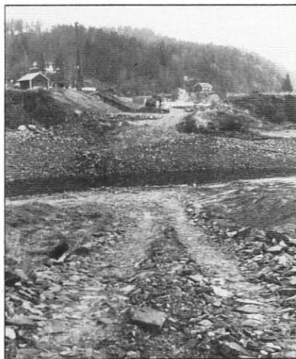
Her skal Storelva bru bygges på peler over elva,
