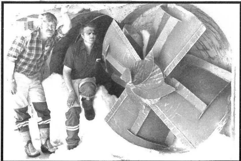
Vegmester Pål Haugen og maskinfører Torleiv Haugen sjekker at den store fresen er klar til å gnage seg gjennom snøfonnene.
