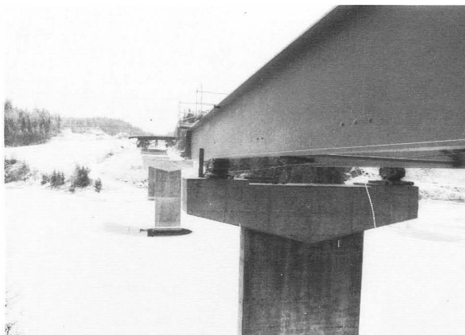
Ny Sundebru vil være ferdig i juni.
