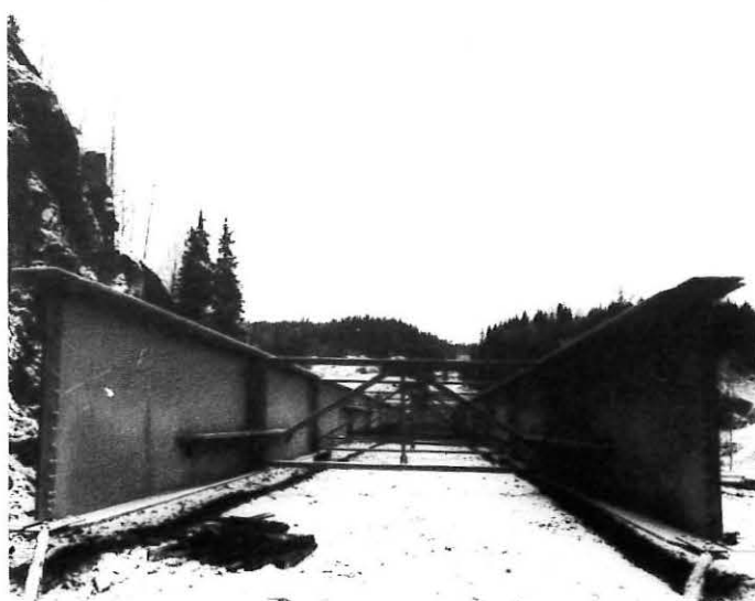
Stålbelegene ligger ferdig montert på østsiden av brua, og skal før sommerferien i år være lagt ut på brukarene over elva.
