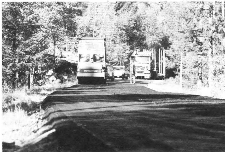
...og valeses før toppdekket legges.
