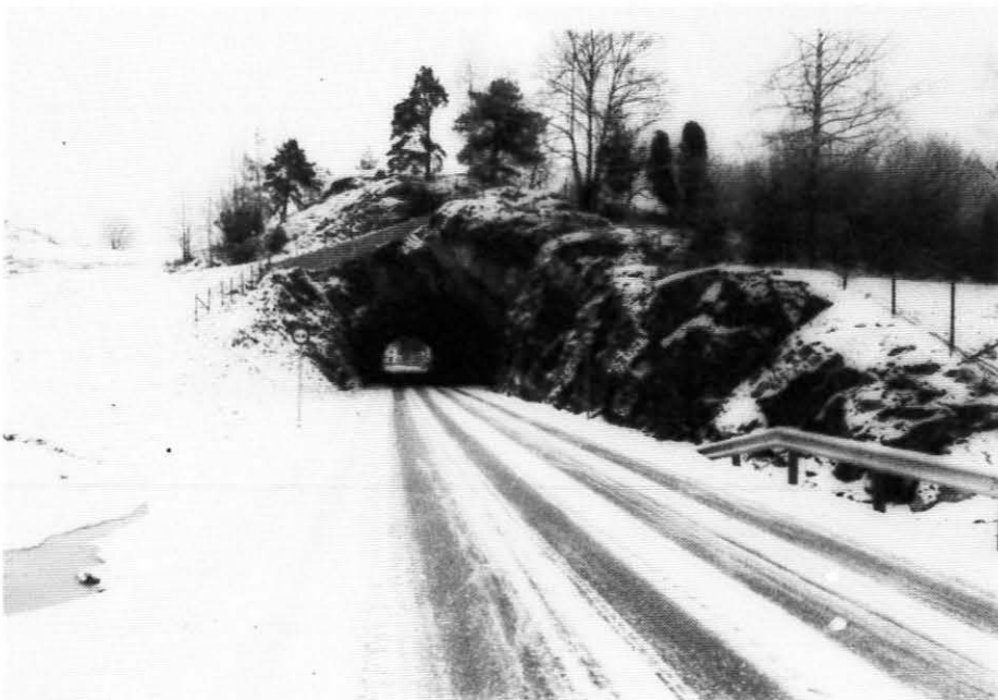
Tunnelen på fylkesvegen Krossen—Gjerstad kirke ble ferdig i fjor
