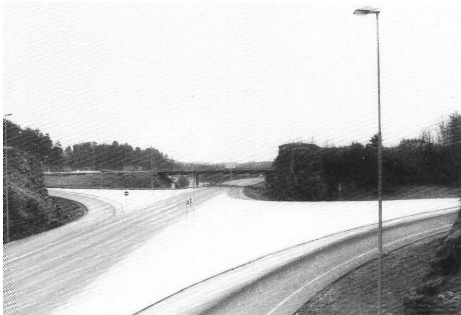
Nytt to-plan kryss ved Harebakken ble ferdig i 1987.
