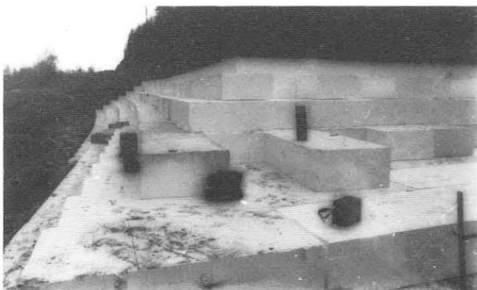
7 lag med Siporex opp på hverandre utgjør nå et stykke av vegfyllingen på E-18 i Nygårdshallingene ved Fiane.
