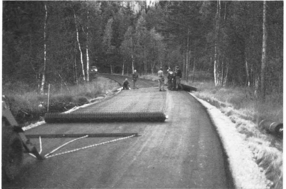
Armeringsnettet rulles ut på avrettet underlag, strekkes,...
