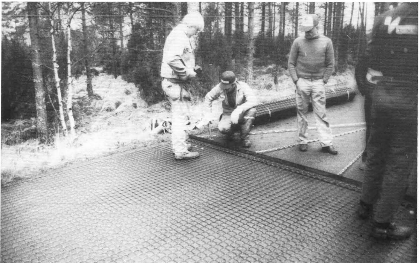
På Gjøvdalsvegen ble det i 1987 lagt plastarmering i dekket.
