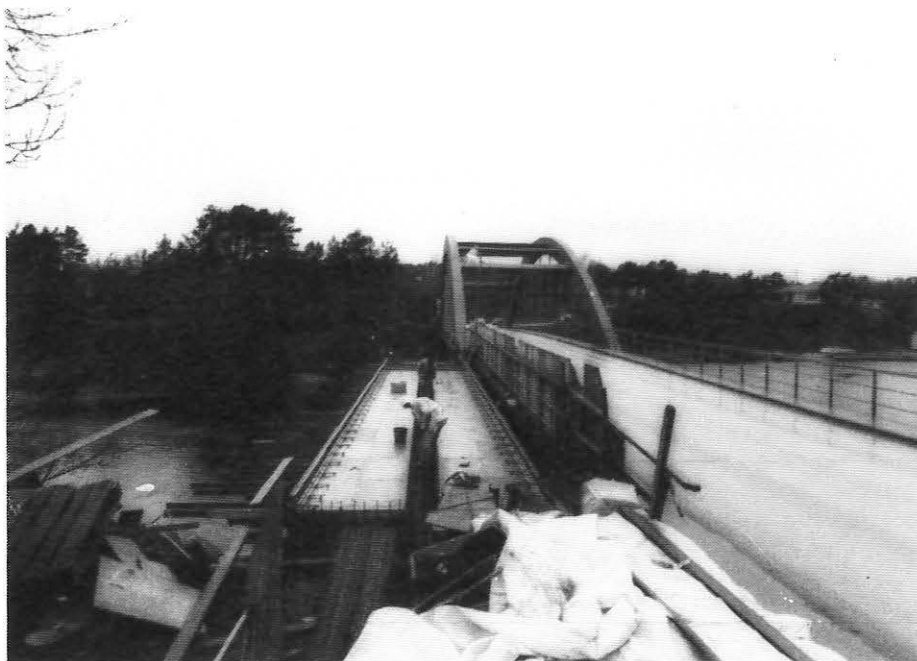
Gang-/sykkelbru er under bygging på utsiden av Vippra bru på Rv. 420.
