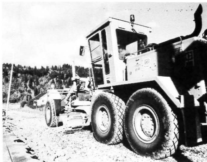
Gjennom Egddalen sentrum og frem til brua legges bærelaget på og «flates ut» med veghøvel.
