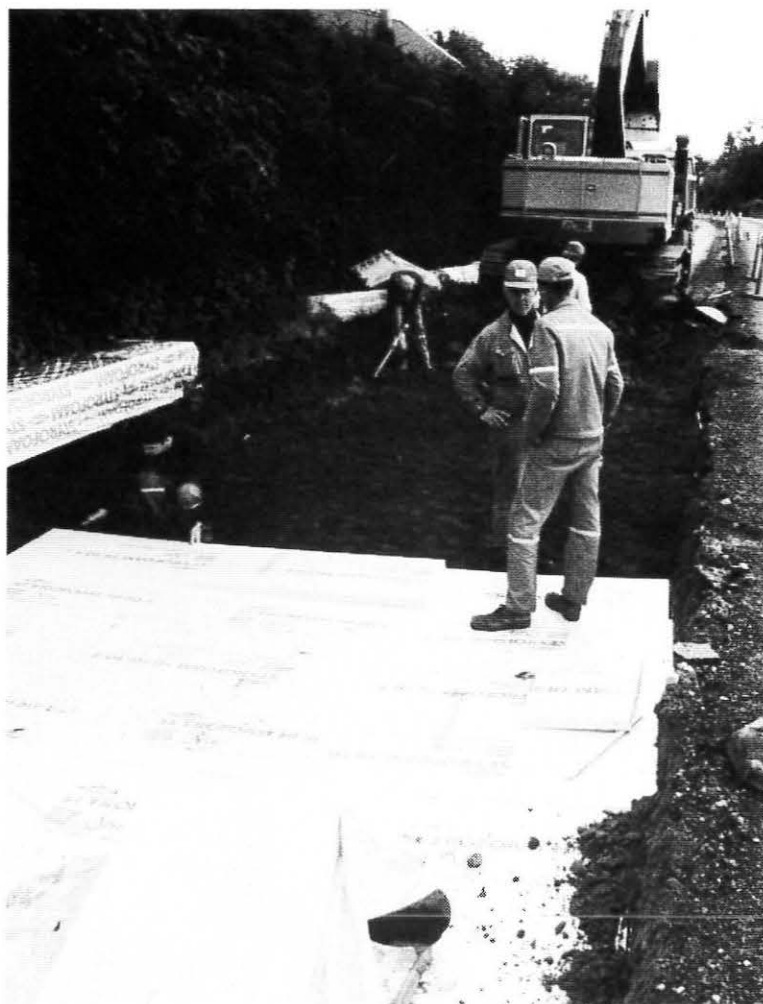
Overbygningen er fjernet ned til 60 cm og isolasjonsplatene legges på plass i Vikbakken.
