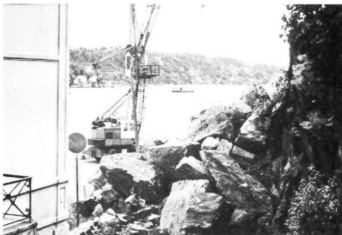
Omlag 3.100 m 3 fjell ble sprengt ut nederst i bakken.
