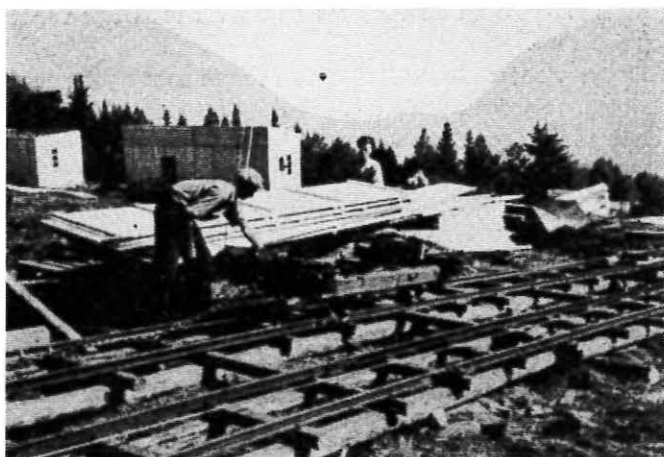
Ved kabelbanens øvre ende. Tralle.
