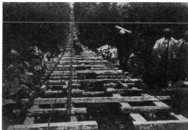
Skinnelegging. Kabelbanen er strukket. Oppkjøring av skinner, sviller etc. foregikk med banen.
