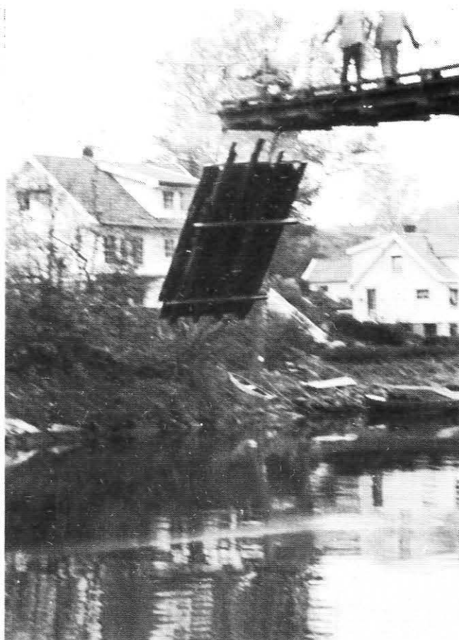
Enda en bit av brua er kappet løs, og ramler ned i Nidelva før den blir tauet i land.
