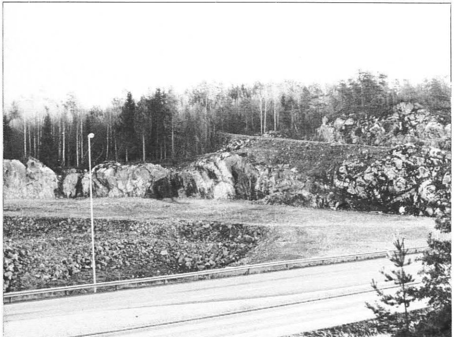
Anleggsvirkksomheten har de siste månedene stått stille ved det nye Harebakken-krysset.
