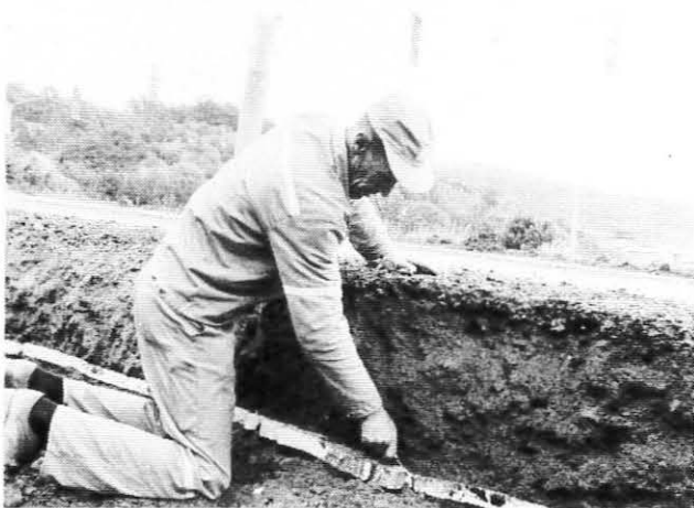
Med kniv renskjæres kantene på isolasjonsplatene før nye legges inn.
