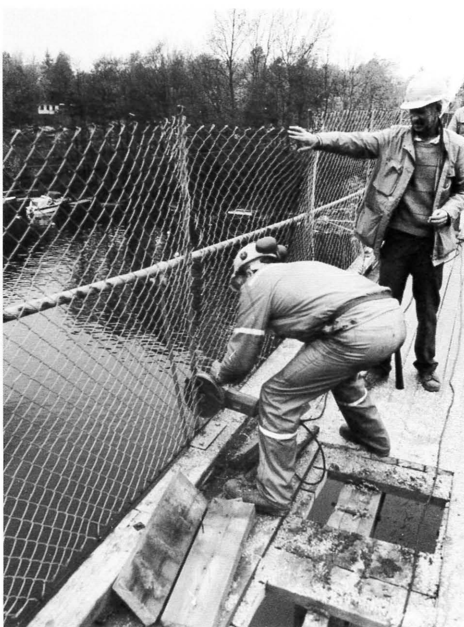
Bit for bit forsvant den gamle Hammeren bru. Både nettinggjerd og brukdekke ble kappet opp i passende lengder
