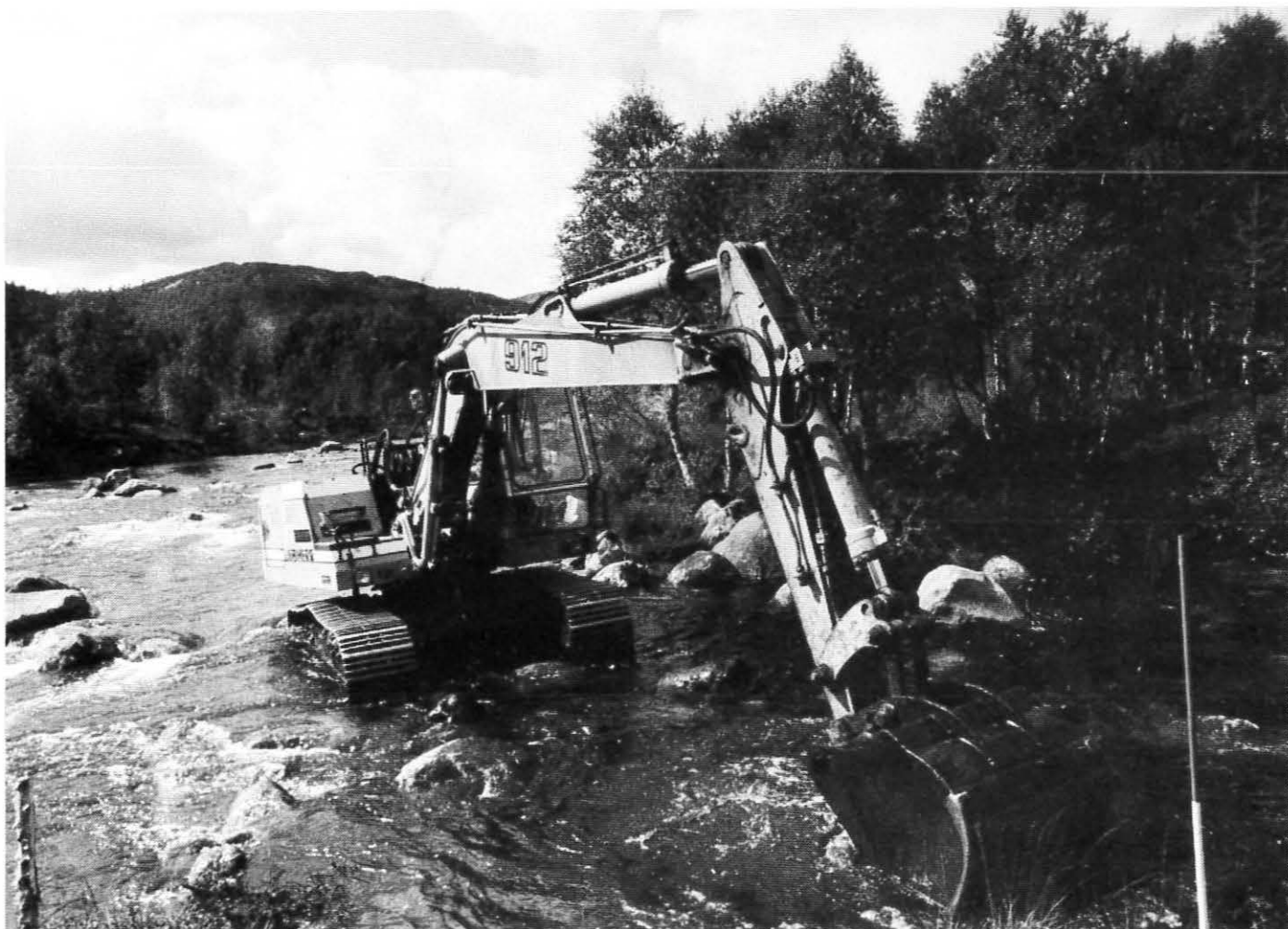
For å få vurdert grunnforholdene for plassering av landkar på noen av bruene, må det tas i bruk skikkelig «grunnbo- ringsutstyr».
