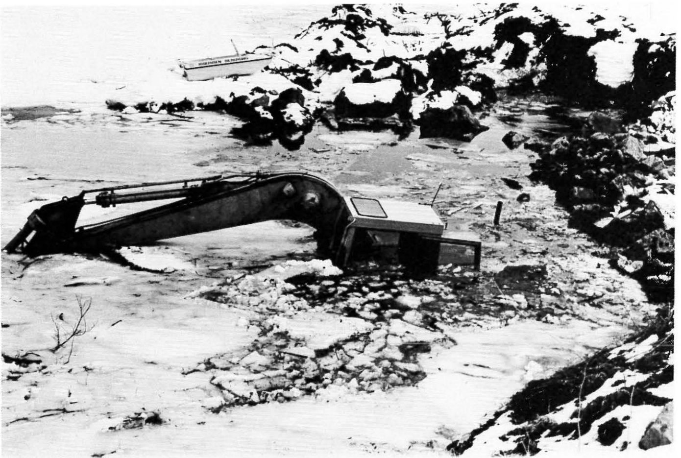
Maskinfører Eivind Ottersland var kaldblodig nok til å slå av motoren på Cat 215 før han reddet seg i land, maskinen ble liggende på denne måten. Foto: OE
