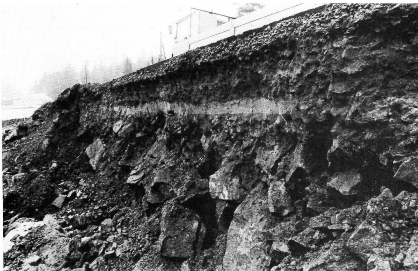
Som med en kniv er raskanten kuttet helt inn til E-18, og en kan «lese» de ulike materialtypene fra asfaltkant og ned til leiren over fjell.
