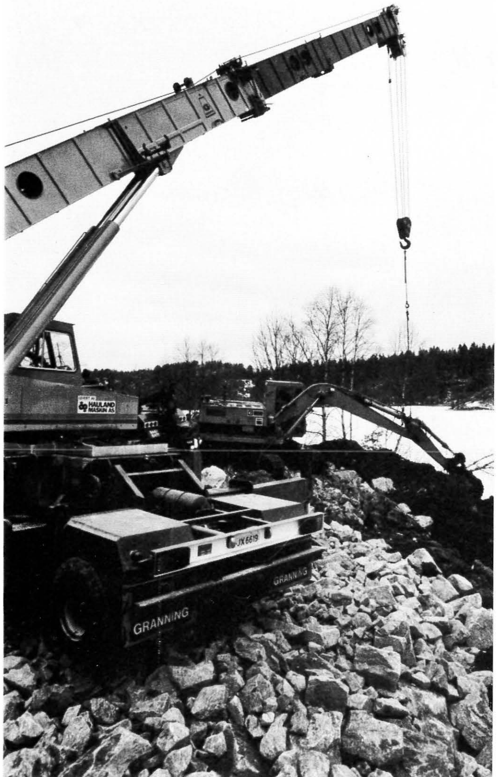
Kraftig utstyr og tunge kraner måtte til for å få hevet catepillaren opp på land igjen.
