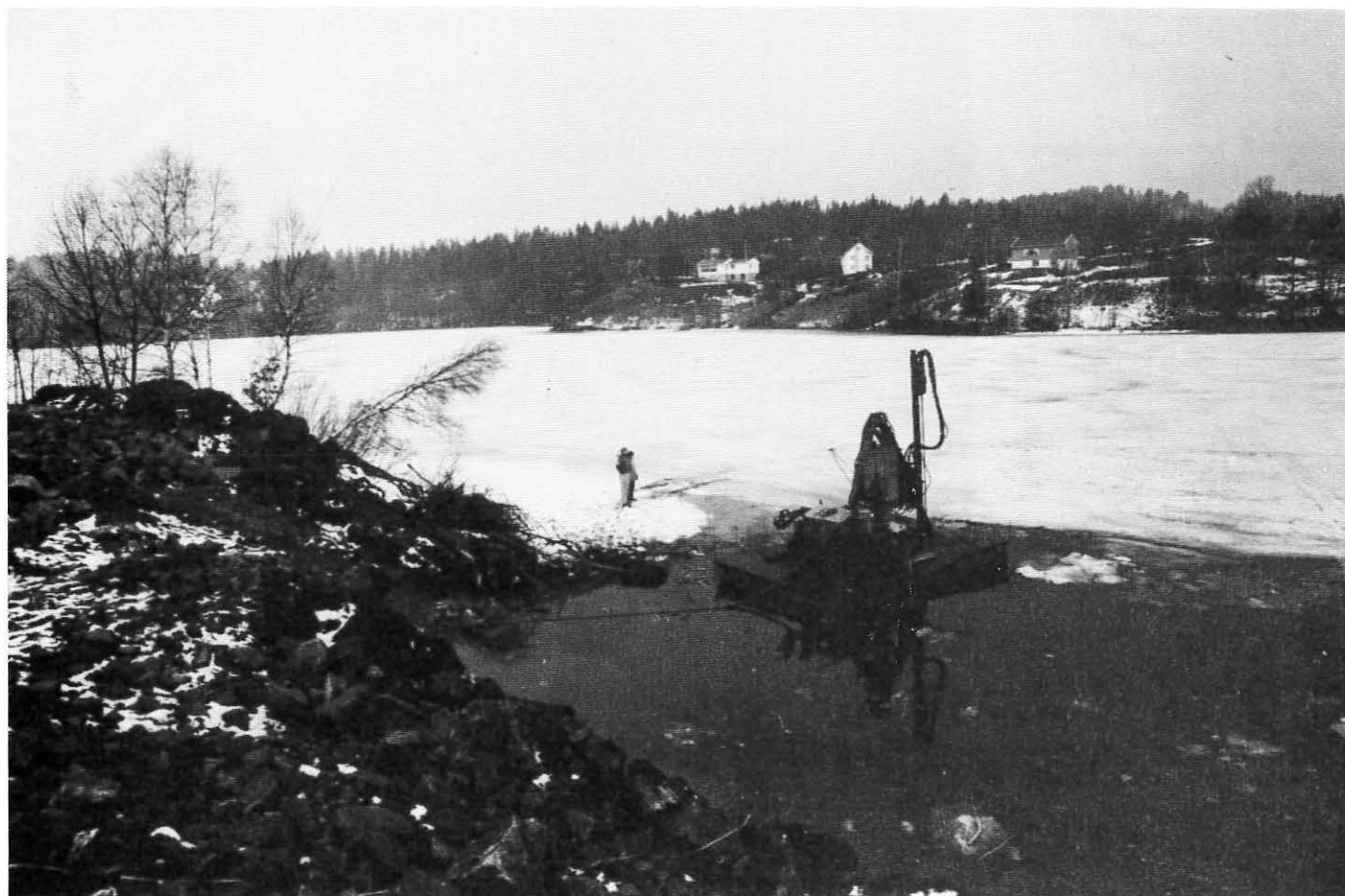
Fjellkontrollboringer med en Roc 311 ble satt i gang umiddelbart etter av gravemaskinen var fjernet.
