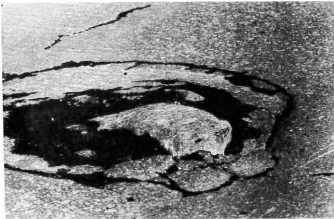
I veger på leirgrunn må selv store stein opp å trekke pusten
