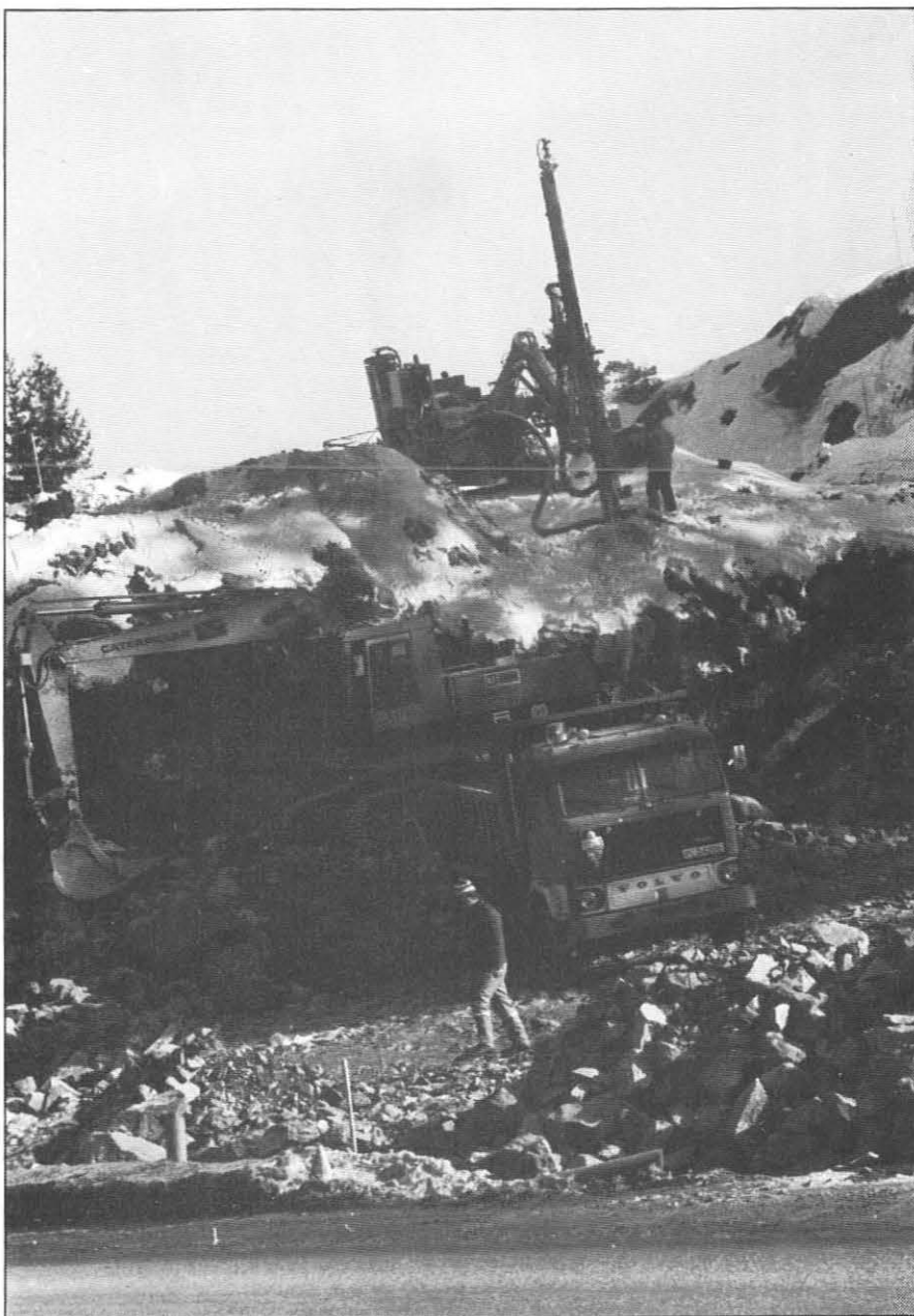
Når utstyret er på topp, går det unna med å fjerne 16.000 m 3 fjell.
