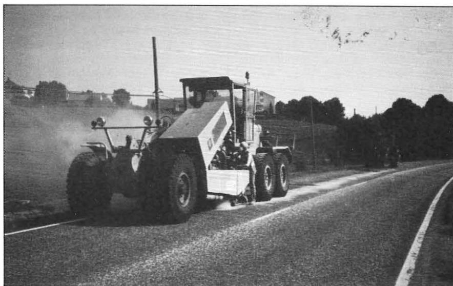
Veghøvel påmontert Tonstad-fres.
