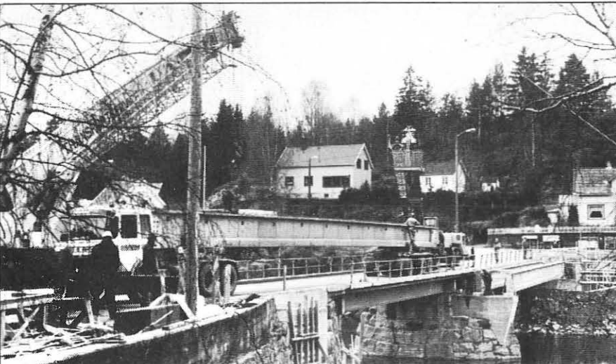
Store løftekraner måtte brukes når de to bjelkene skulle monteres på plass oppstrøms gammel bru.
