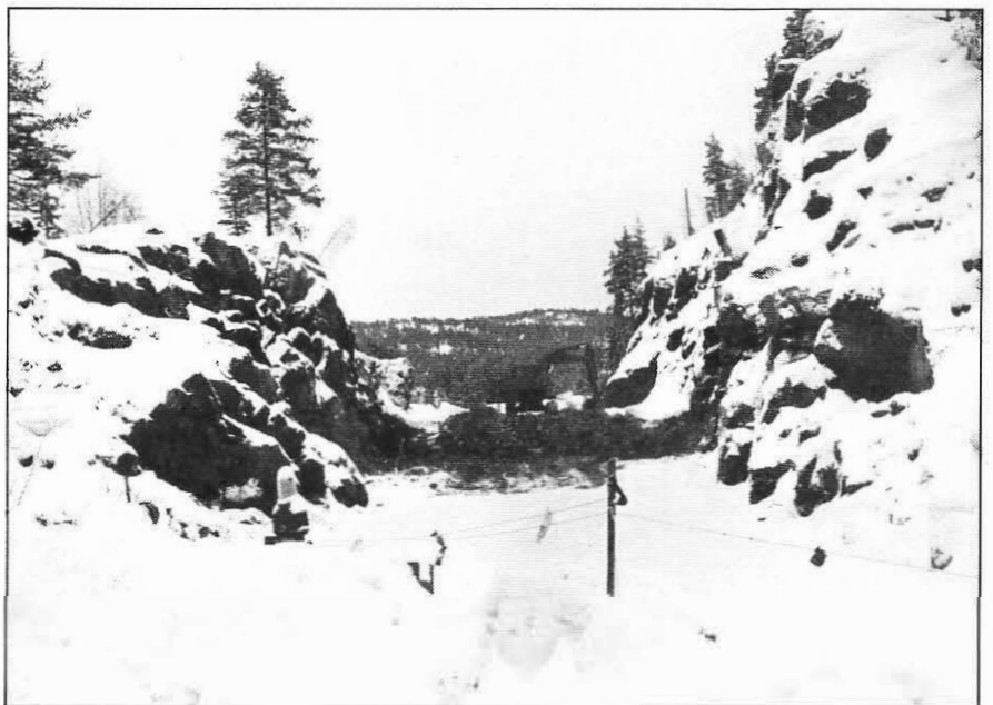
På riksveg 9 i Vågsdalen — mellom Mykland og Vegusdal — har anleggsavdelingen i løpet av vinteren sprengt vekk den ca. 30 meter lange tunnelen. De nærmere 10 000 m 3 fjellmassene som er sprengt bort, er benyttet til omlegging/utbedring av vegen på begge sider av den gamle tunnelen. I anleggsperioden har en kunnet legge trafikken inn på «gamle» riksveg 9, som går rundt fjellet på venstre side av bildet.
