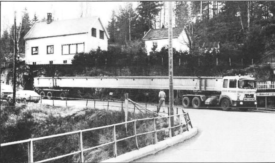
Transporten av en 29,2 m lang bjelke kunne by på problemer, særlig under innkjøring på Sunde bru fra vest.
