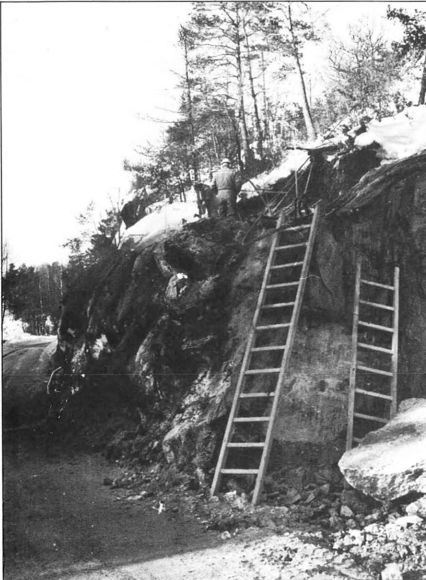
Kulde, snø- og isproblemer hindrer ikke de ansatte i vedlikeholdet i å foreta nødvendig vegutvidelse.
