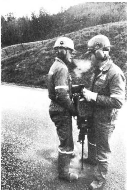
Det bores først et hull ned til over 2 m
