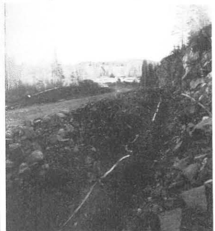
Et parti av fylkesveganlegget sett mot Myra. Parallelt med vegen legges vann- og kloakkledning på samme side som fremtidig gang/sykkelsti
