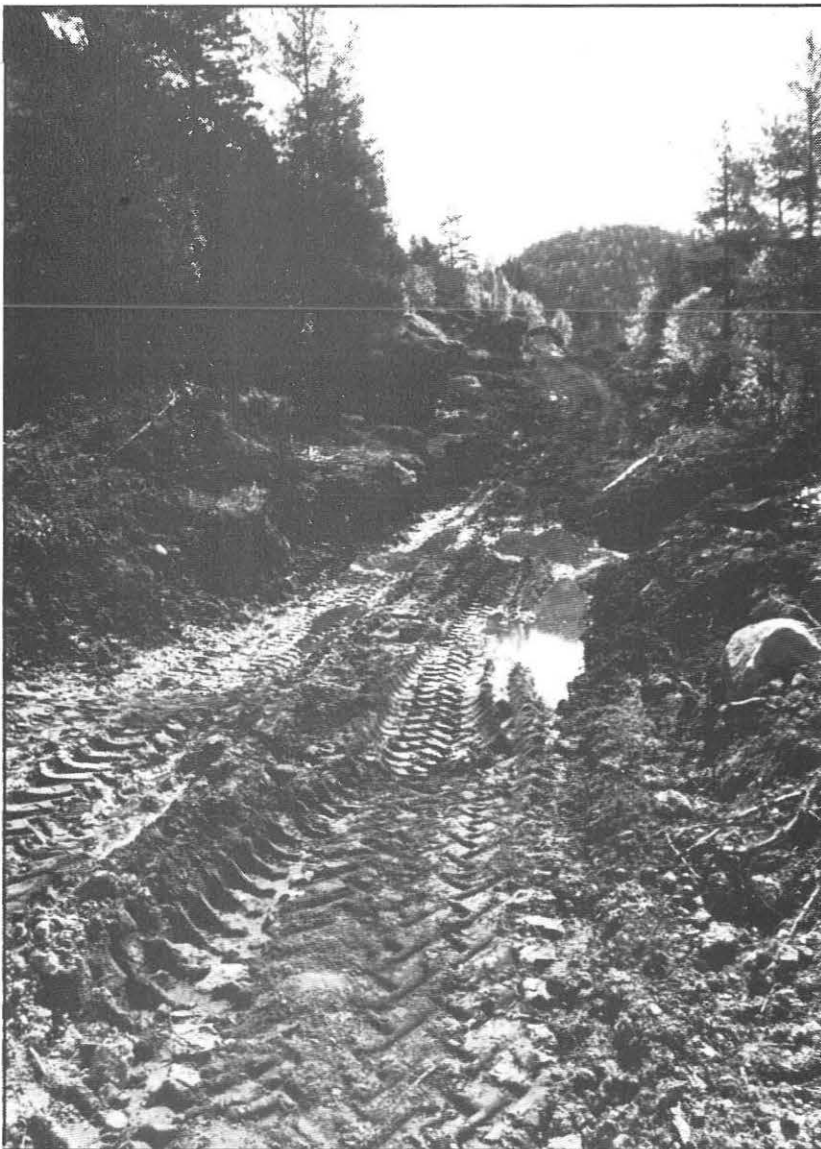
Det måtte bygges anleggsveg inn fra Trydal
