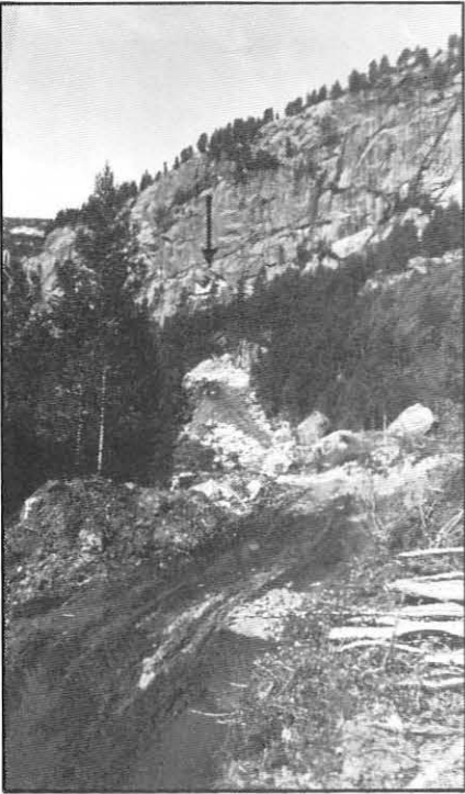
Tunnelinnslaget ved Motjørni
