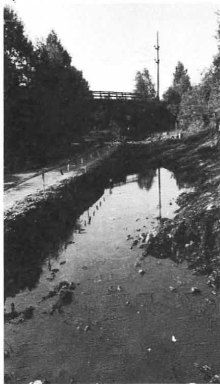
På rv. 414 ved jernbaneudergangen på Vegårshei, er et lag i arbeid med å senke vegbanen, slik at fri høyde under brua blir 4,10 m.
