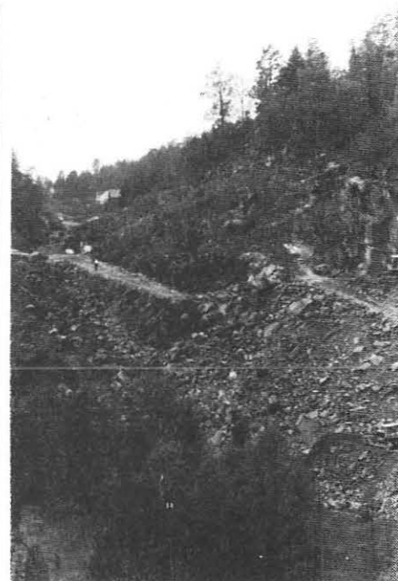
Fra skjæringstopp til fyllingsfot kan det være 20 meter høydeforskjell.
