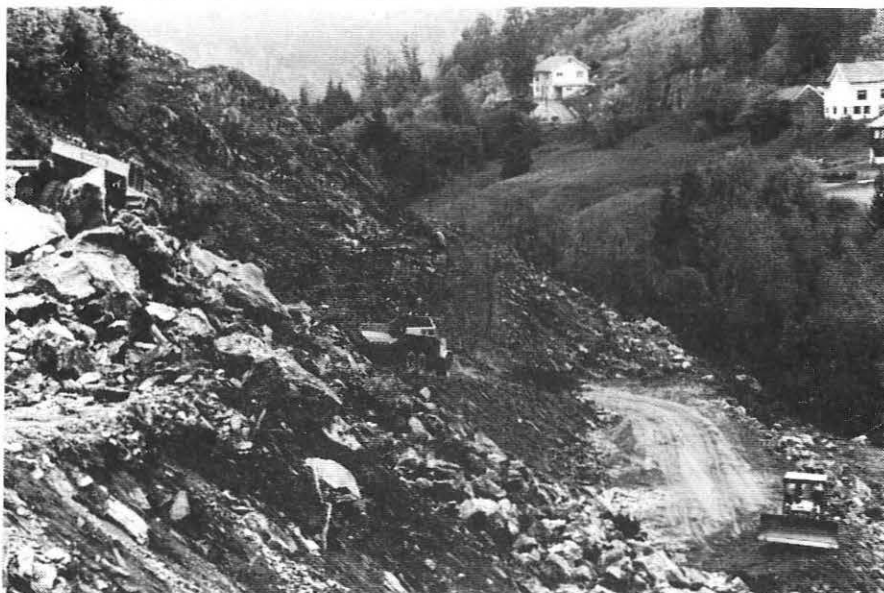
Massetransport foregår fra flere plan i det kupert terrenget.
