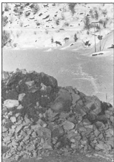
Det er antatt at ca 80 000m 3 fyllmasse vil gå med over bykta
