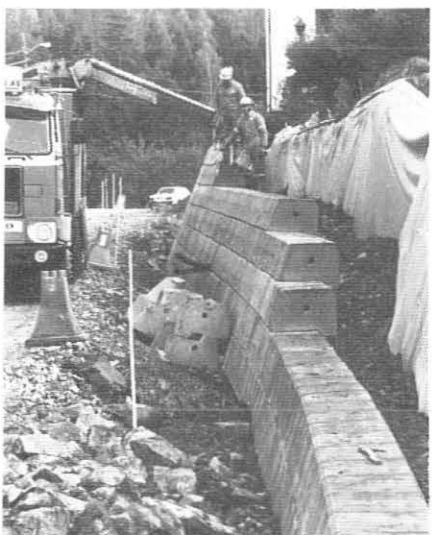
Trøndermur monteres ved riksveg 415
