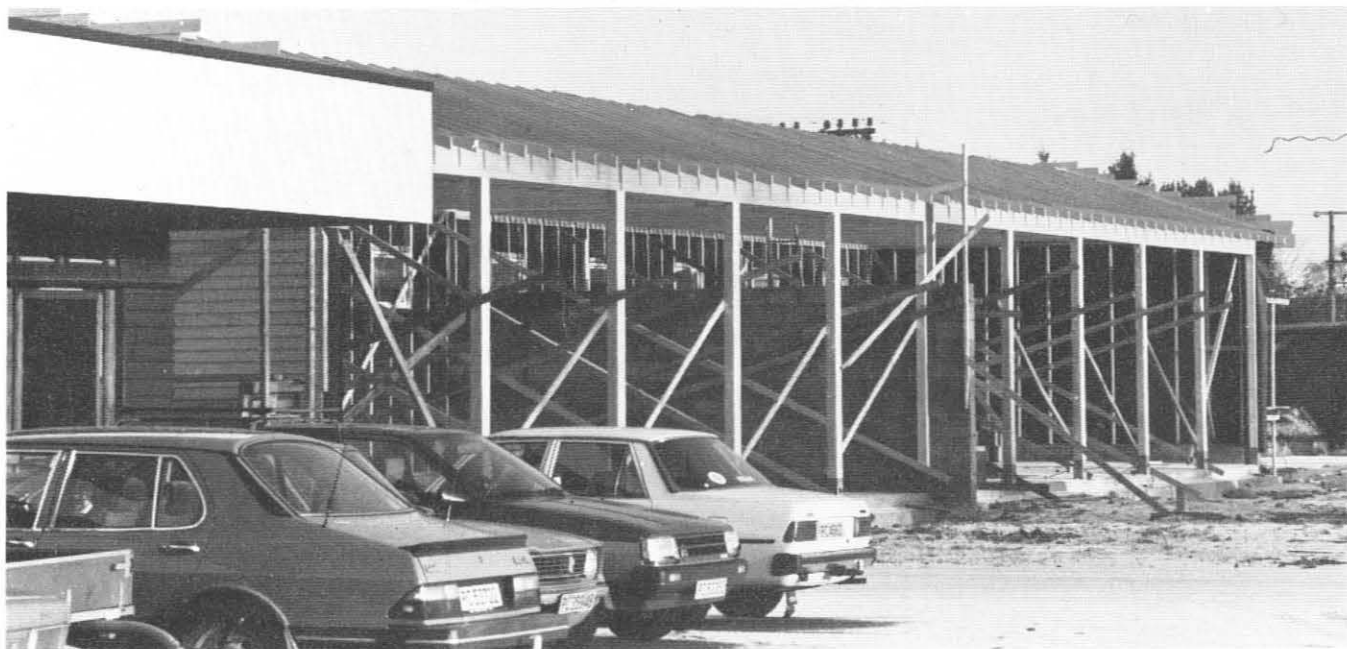
Det nye lagerbygget på Skarpnes tar form
