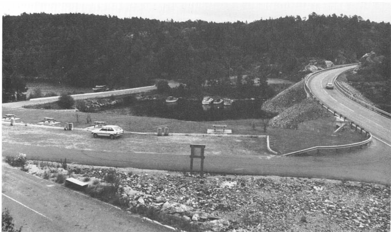
E-18 Svennevik bru med omliggende friluftsområde er et resultat av godt samarbeide mellom Miljøverndep. og Aust-Agder Vegvesen.
