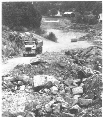
Det blir høy fylling ned mot Løddesølvegen
