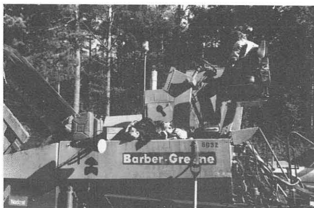
Radar, avlesningskjerm og operatør plassert på utleggeren
