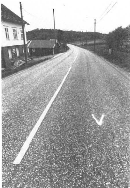
Varsellinje (V) består av 9 meter lange gule striper med 3 meters mellomrom.
