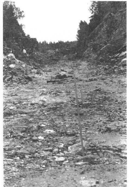
4000 m 3 fjell i skjæringen ved Selde bro
