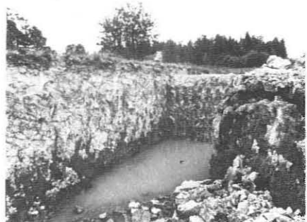
Anlegget byr også på geotekniske problemer
