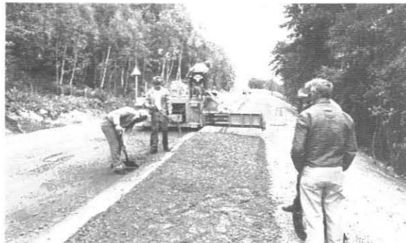
Oppfylling og avretting av fortau før asfaltering
