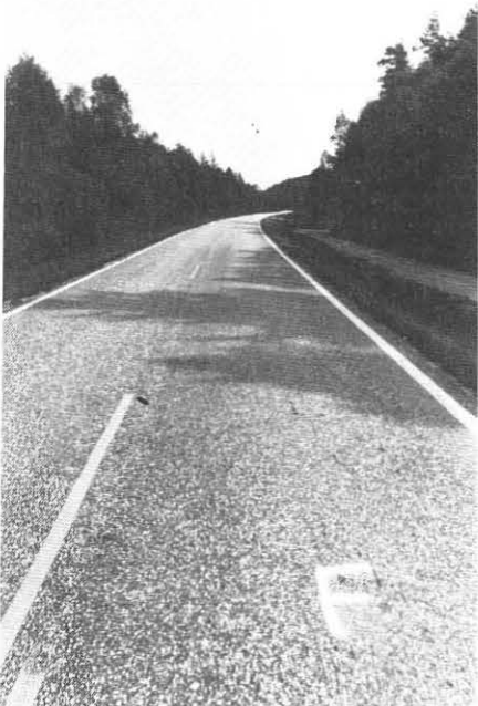
Kjørefeltlinje (F) betyr sikt til forbi kjøring i begge kjøreretninger og er merket med striper à 3 meter med 9 meters mellomrom.
