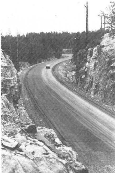
700 meter av i alt 4030 er ferdig bygget
