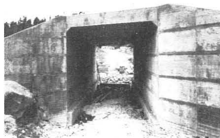
Kulvert som fører til nybygget lokalveg
