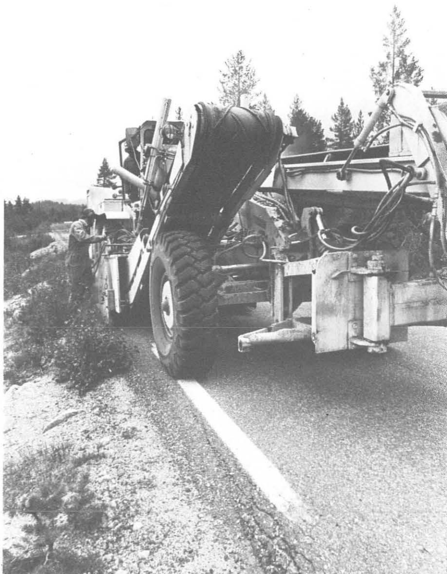
Fresemaskinen trenger kun maskinfører og en hjelpemann
