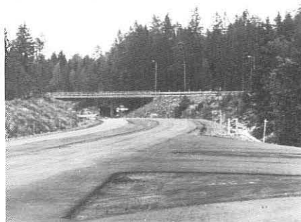
Ferdig veg med avkjørsel til Bjorbekk
