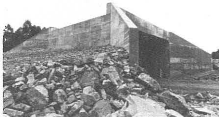
Kulverten over Løddesølvegen koster kr. 800 000,-
