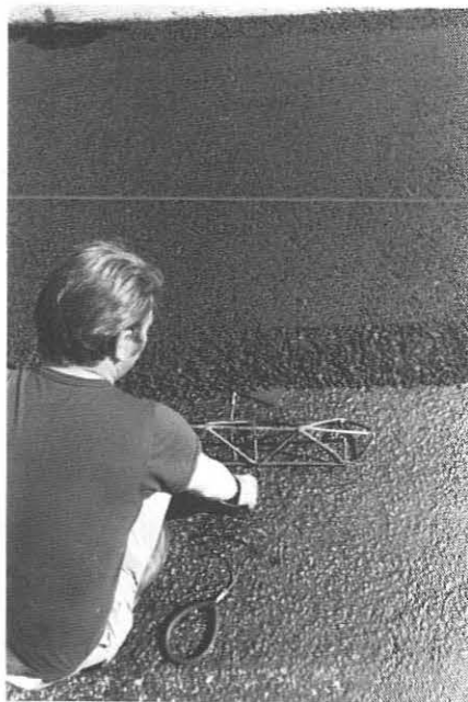
Utleggeren er kjørt forbi, prøveplaten kan tas opp
