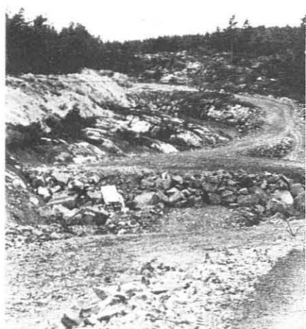
13 000 m 3 fjell skal sprenges her
