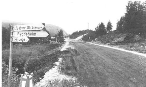
Den utvidede parsellen sett mot samvirkelaget
