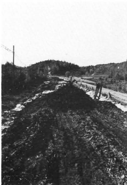
Parallellt med utfylling av bark, sørger gravemaskinene for masseutskifting i forkant av tippet.
