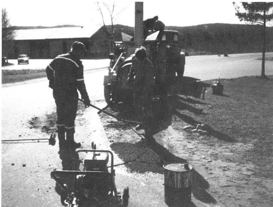
Det er viktig at forarbeidet er grundig gjort før gjenlapping.
