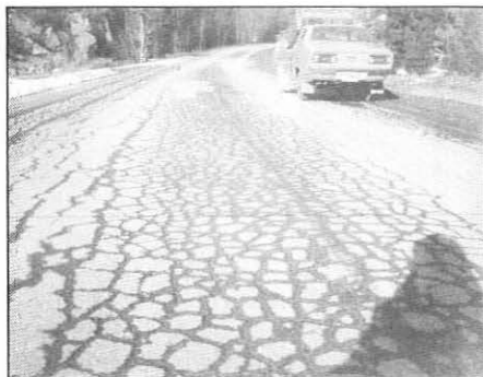
Ved krakelering kan legges et enkelt Ottadekke.
