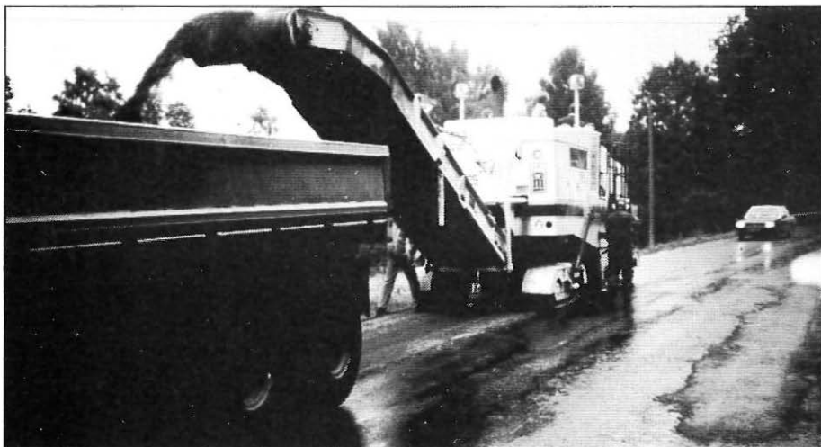
Kald vekkfresing av langsgående rygger på E18 ved Skjulestad.
