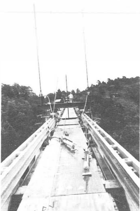
Dragerne ble dratt over ved hjelp av jekker
