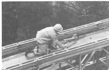
Justering i lengderetningen foretas
