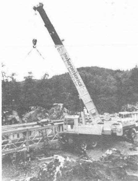
Fagverket ble lagt ut ved hjelp av kranbil
