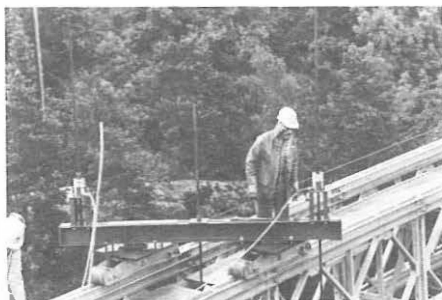
Avd. ing. Gunnar Haugen kontrollerer nedjekkningen av dragerne
