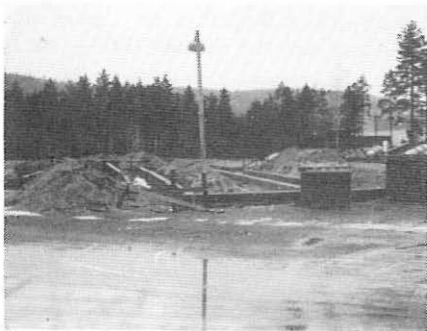
Fundament for nytt kontorbygg
