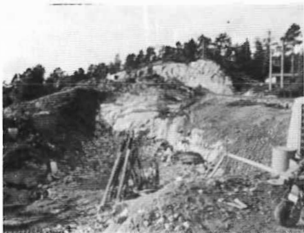
Fra tunnelinnslaget ved Bie
